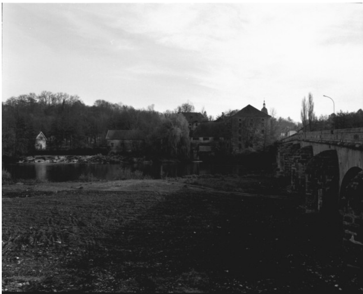
Vue d'ensemble depuis l'ouest en 1989.
