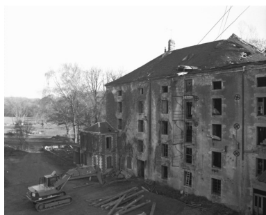
Façade antérieure du moulin public en 1989.
