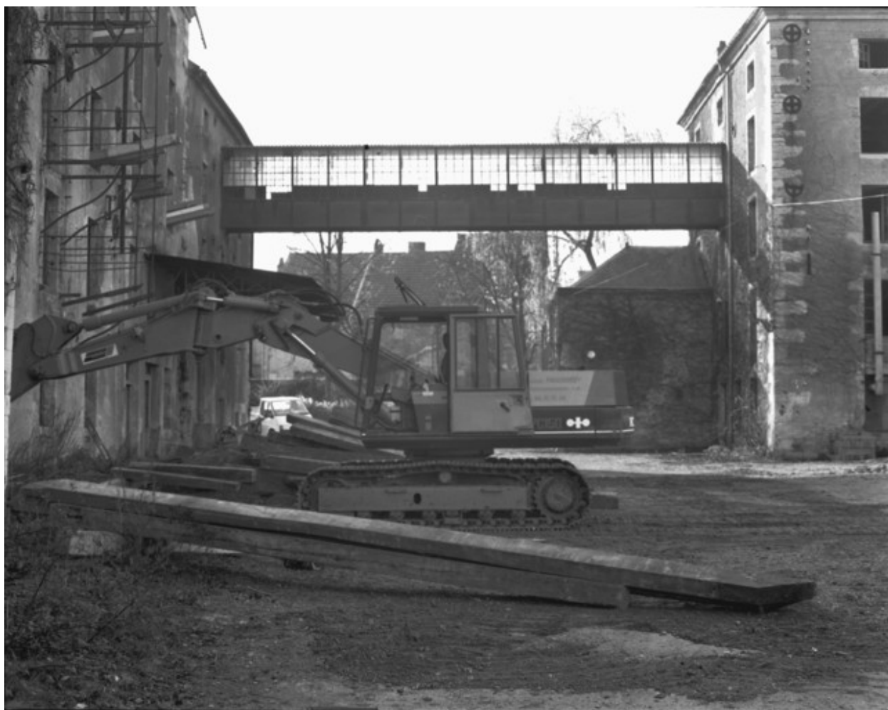
Vue rapprochée de la passerelle en 1989.
