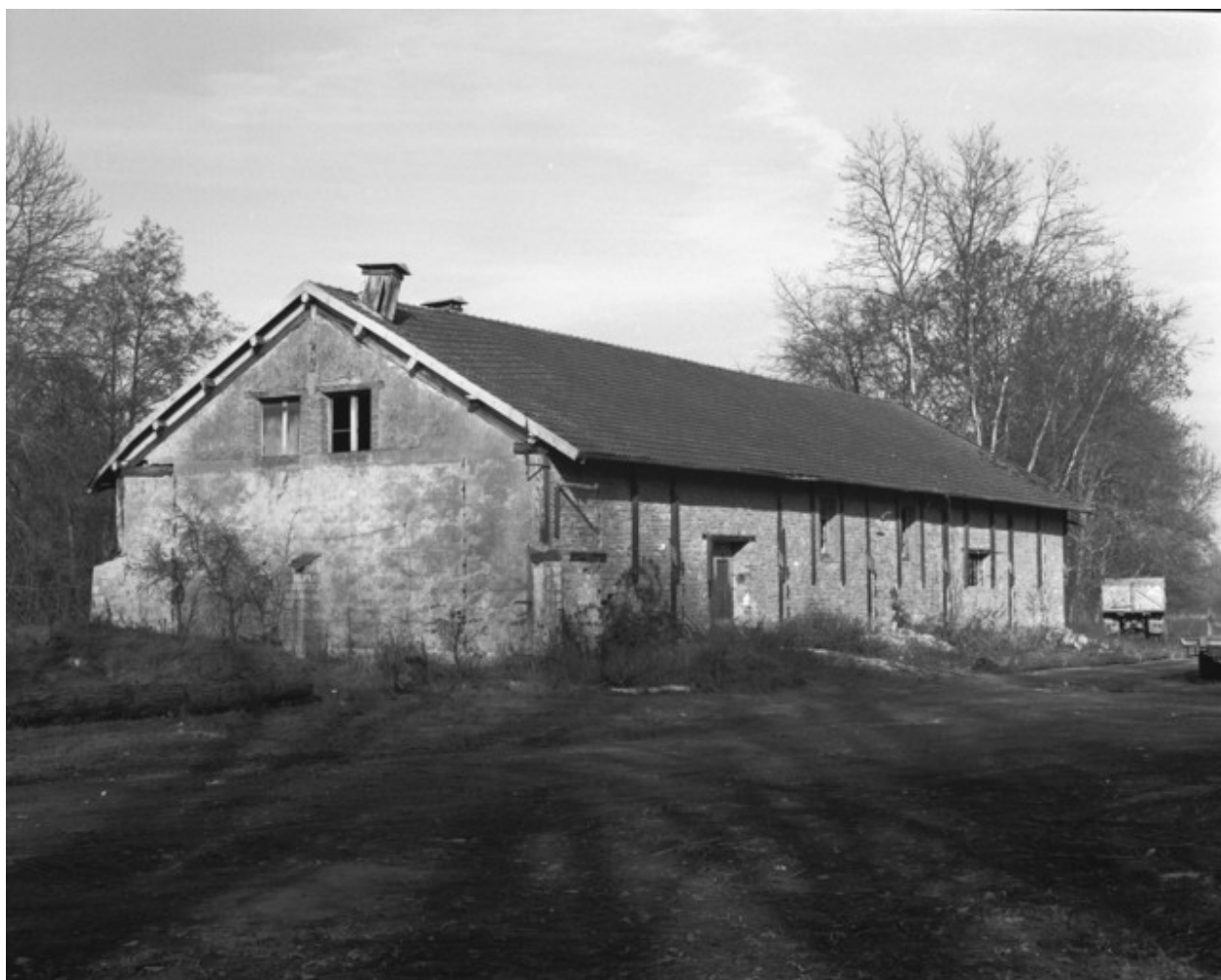
Vue rapprochée de l'entrepôt industriel en 1989.
