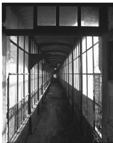
Intérieur de la passerelle en 1989. Phot. Yves Sancey IVR43_19897000966X
