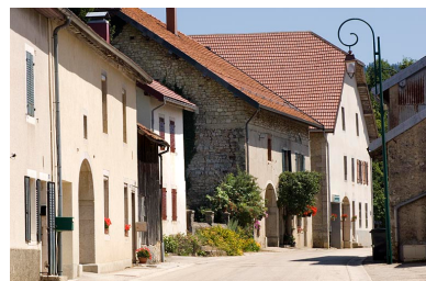
Fermes situées rue du Faubourg. Phot. Jérôme Mongreville IVR43_20092500959NUC2A
