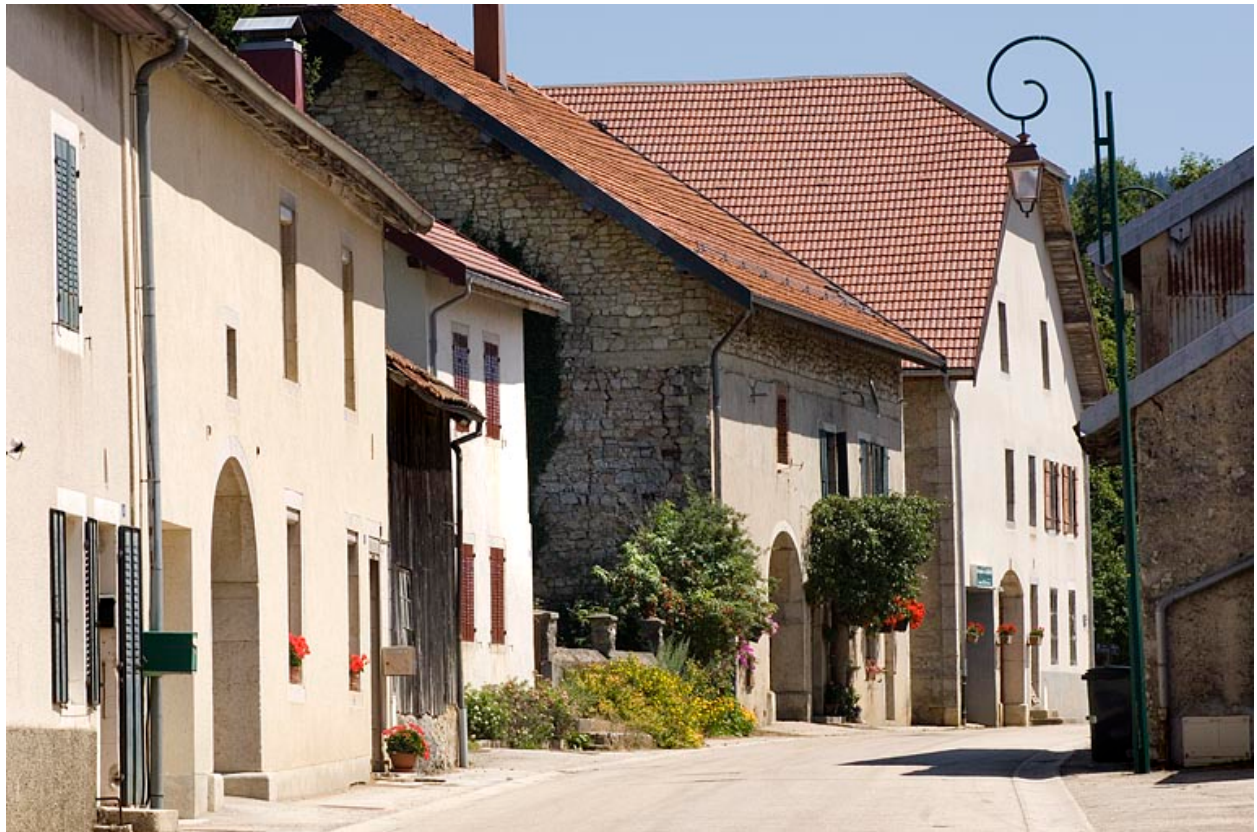
Fermes situées rue du Faubourg.
