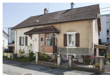
Maison jumelée. Phot. Jérôme Mongreville IVR43_20112502064NUC4A
