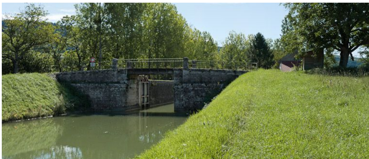
Vue du pont depuis l'aval.
