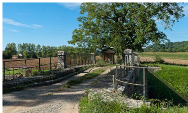
Vue du pont. Phot. Pierre-Marie Barbe-Richaud IVR26_20112103878NUC4AQ
