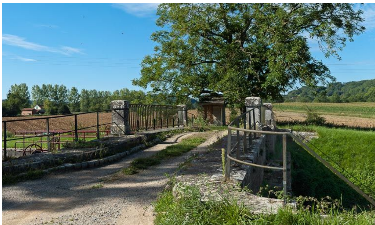
Vue du pont.
