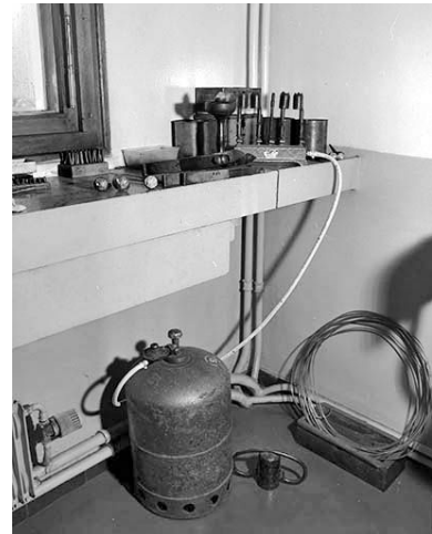
Vue d'ensemble du bec de gaz. Phot. Jérôme Mongreville IVR43_20013900029X
