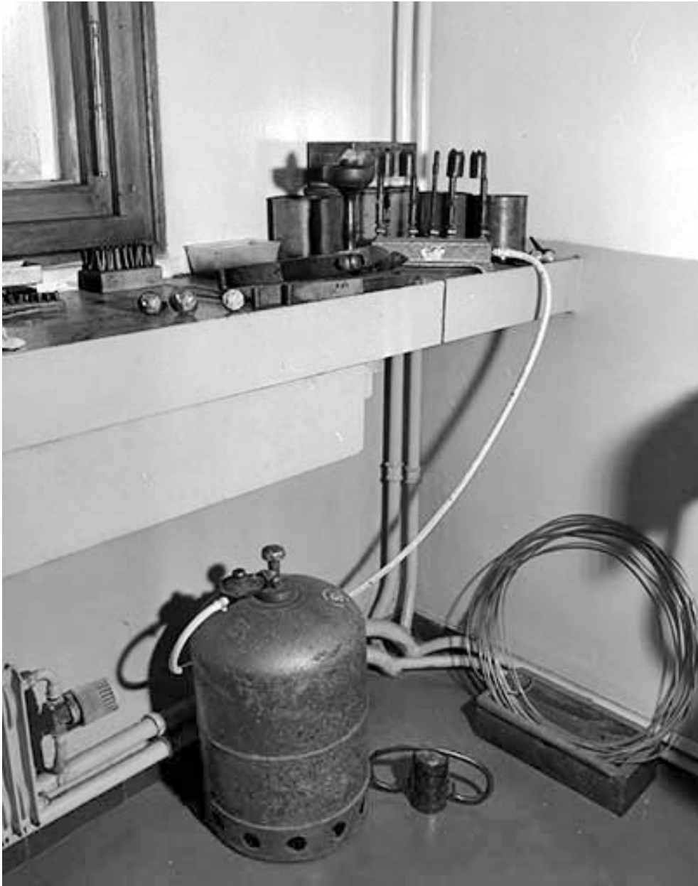
Vue d'ensemble du bec de gaz.
