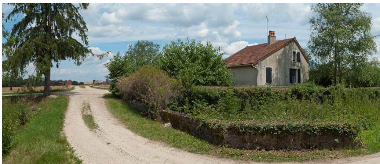
Vue de l'arrière de la maison éclusière.
