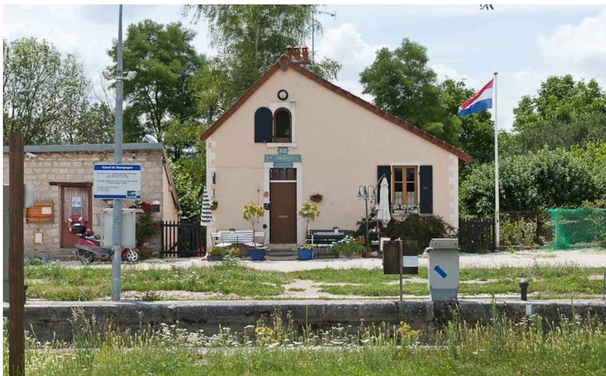
Vue de face de la maison éclusière.
