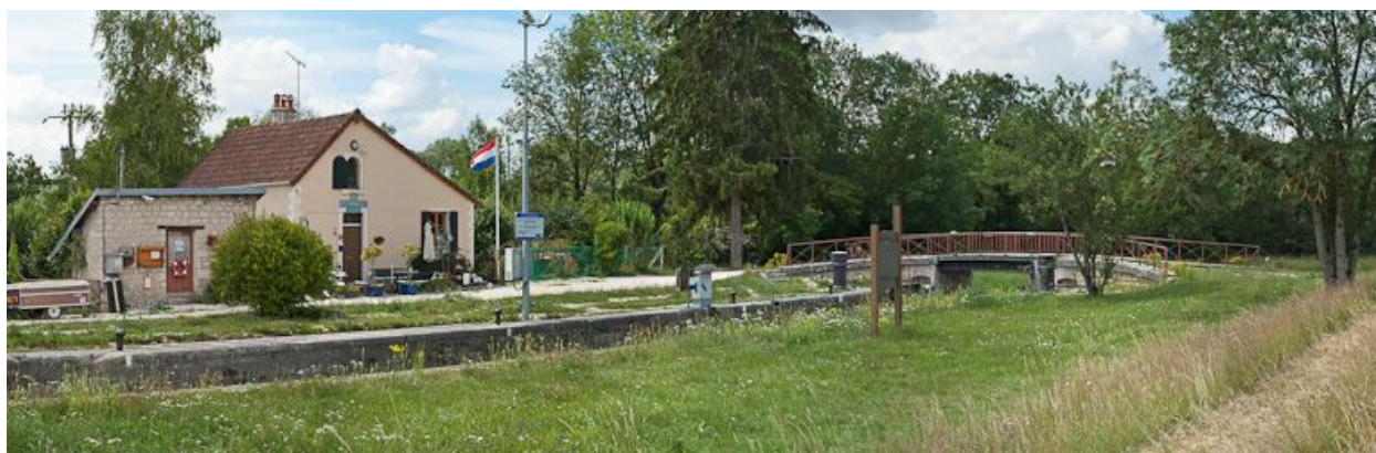
Vue d'ensemble du site d'écluse.
