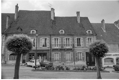
Façade sur rue. Phot. Bernard Lardière IVR43_19817000837Z
