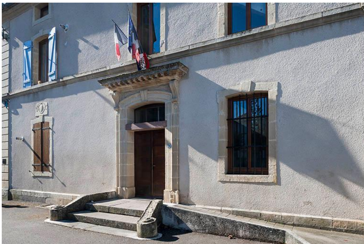
Entrée de la mairie, façade Nord.
