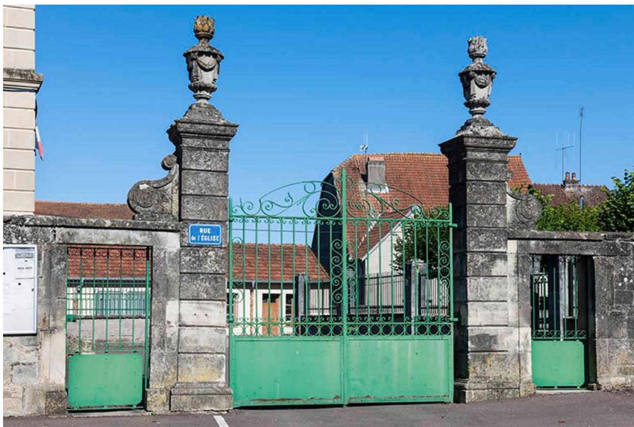
Portail d'entrée de la mairie.
