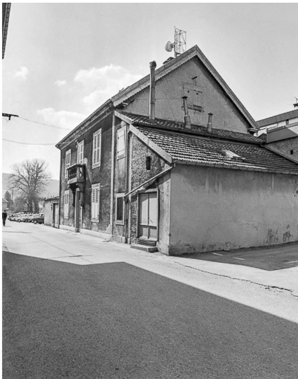
Façades sur rue et latérale droite.
