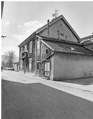
Façades sur rue et latérale droite. Phot. Yves Sancey IVR43_19802500242X
