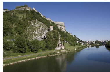
Vue d'ensemble du quai depuis l'amont. Phot. Yves Sancey IVR43_20062500157NUCA
