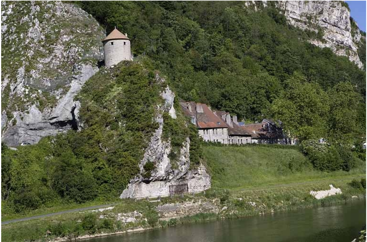
Vue d'ensemble rapprochée du quai.
