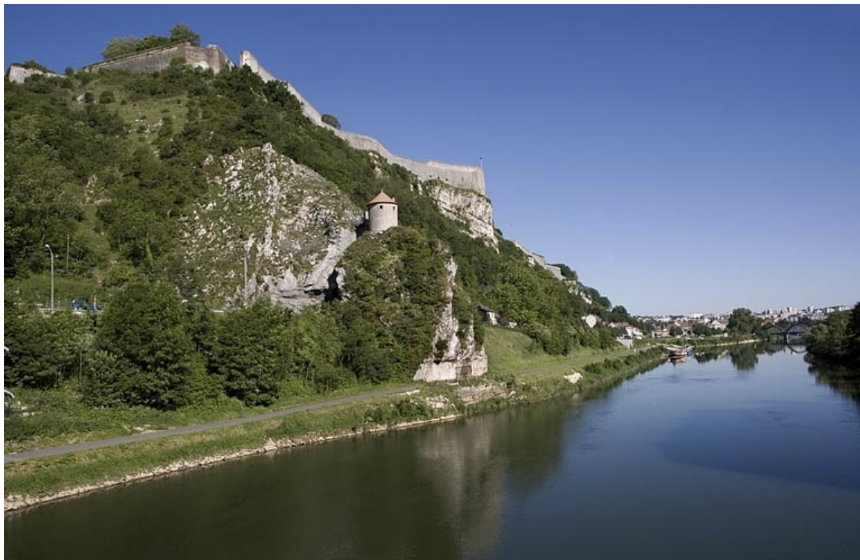
Vue d'ensemble du quai depuis l'amont.
