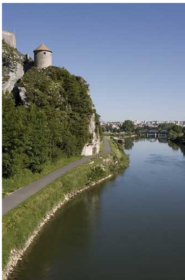
Vue d'ensemble du site depuis l'amont. Phot. Yves Sancey IVR43_20062500156NUCA
