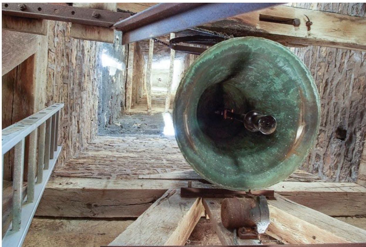
Vue depuis le plancher du beffroi.
