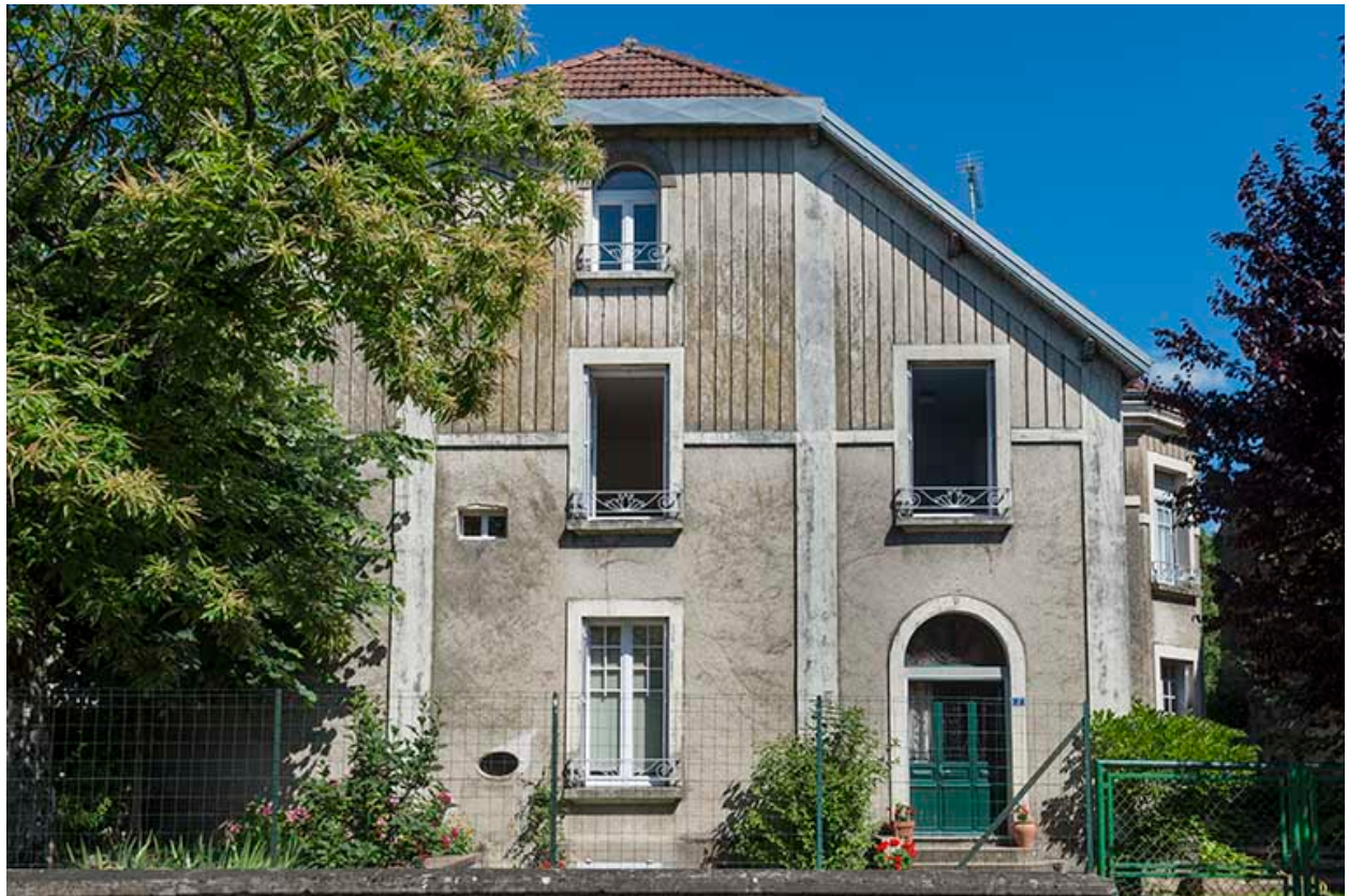
Maison côté rue de la Perception.
