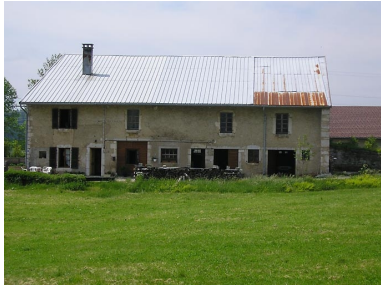
Vue de la façade antérieure. Phot. Marie-Pierre Reynet IVR43_20083900014NUC1A
