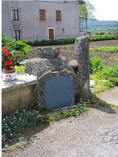
Vue de la citerne. Phot. Marie-Pierre Reynet IVR43_20083900015NUC1A
