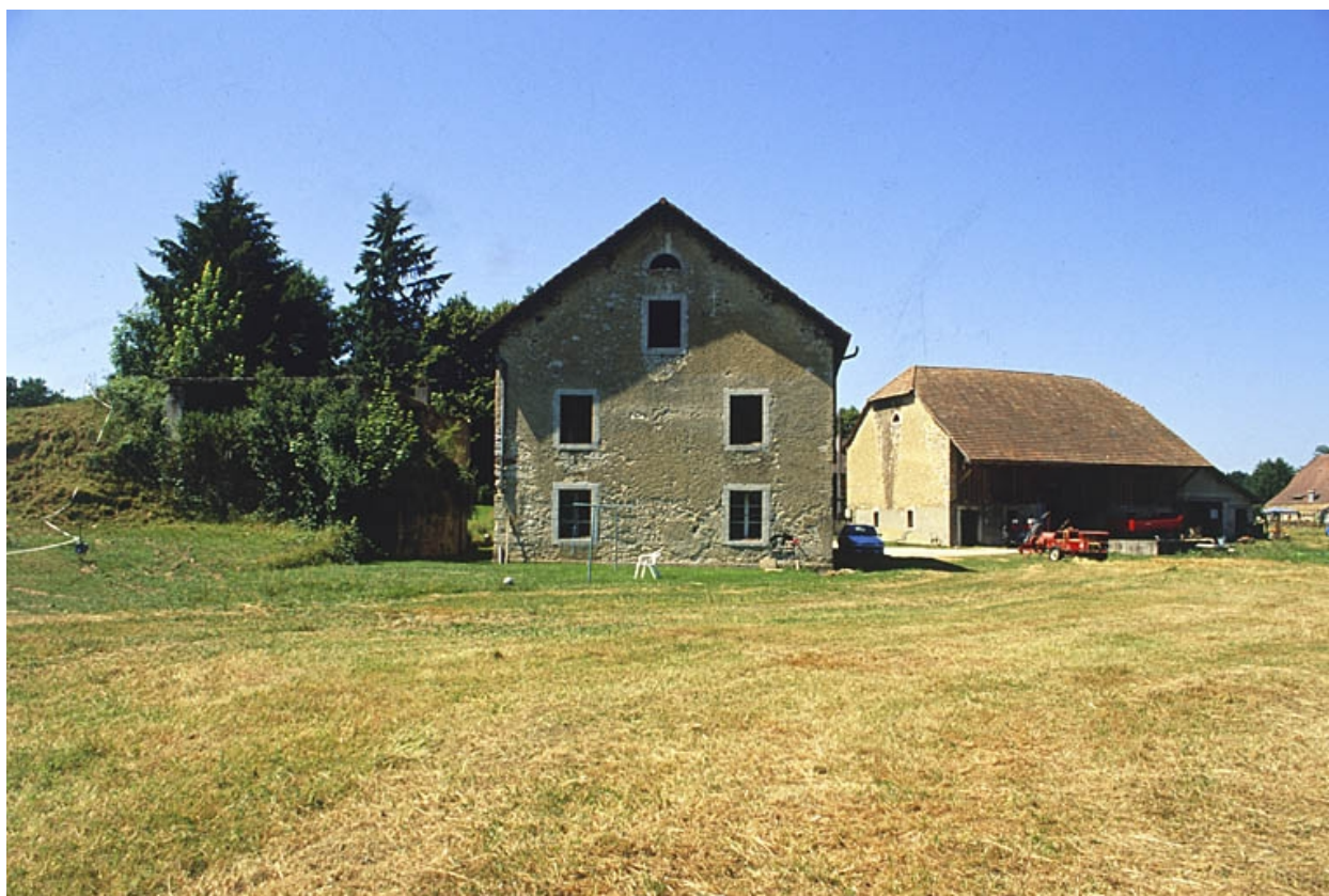
Mur-pignon nord du moulin.
