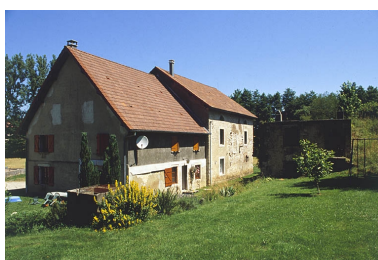
Vue de trois quarts arrière. De gauche à droite : logement, moulin et chambre d'eau. Phot. Yves Sancey IVR43_20009000520ZA
