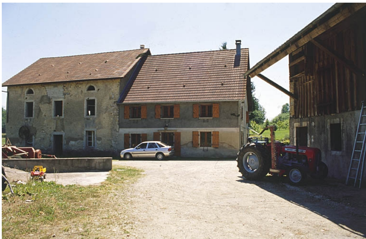
Façade antérieure du moulin et du logement.
