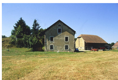
Mur-pignon nord du moulin. Phot. Yves Sancey IVR43_20009000526ZA
