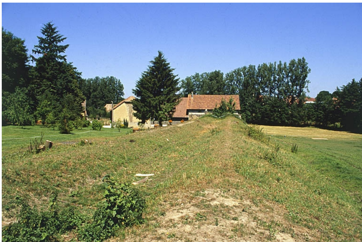
Le canal d'amenée du moulin (comblé).
