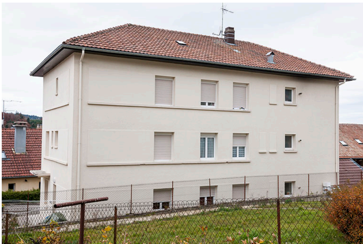
Usine : façades postérieure et latérale droite.
