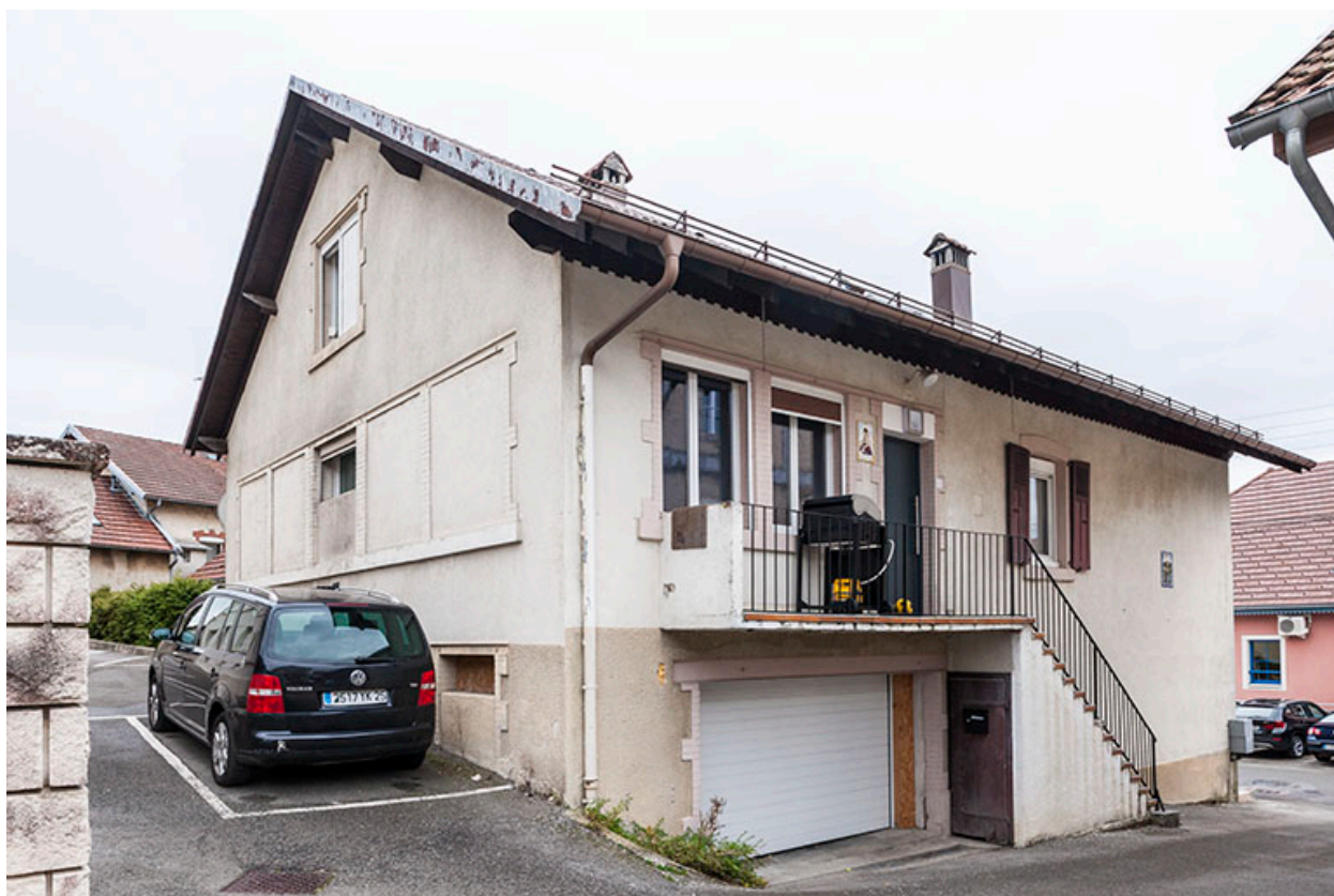
Maison : façades postérieure et latérale gauche.
