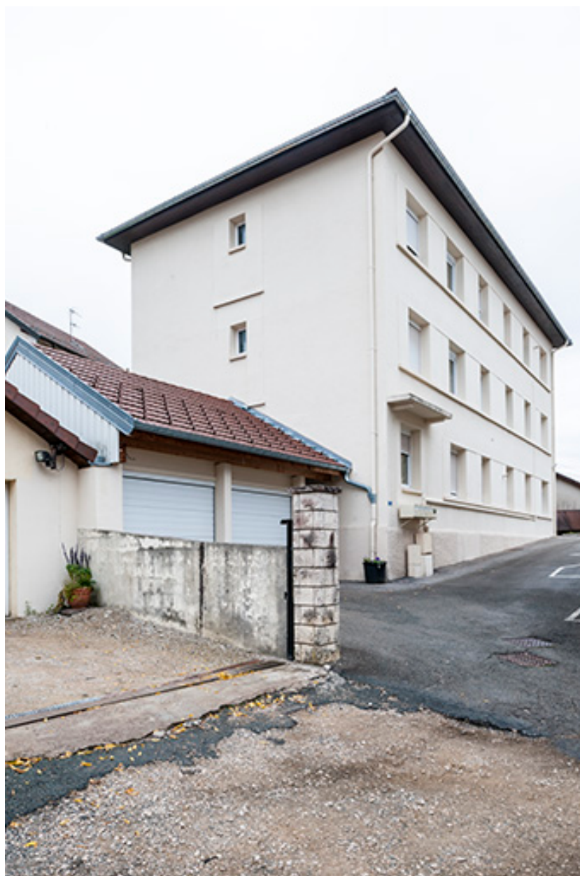
Usine : façades antérieure et latérale gauche.
