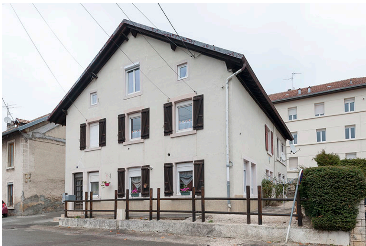
Maison : façades antérieure et latérale droite.
