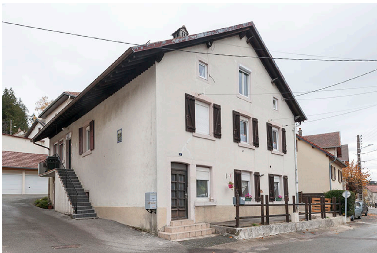
Maison : façades antérieure et latérale gauche.
