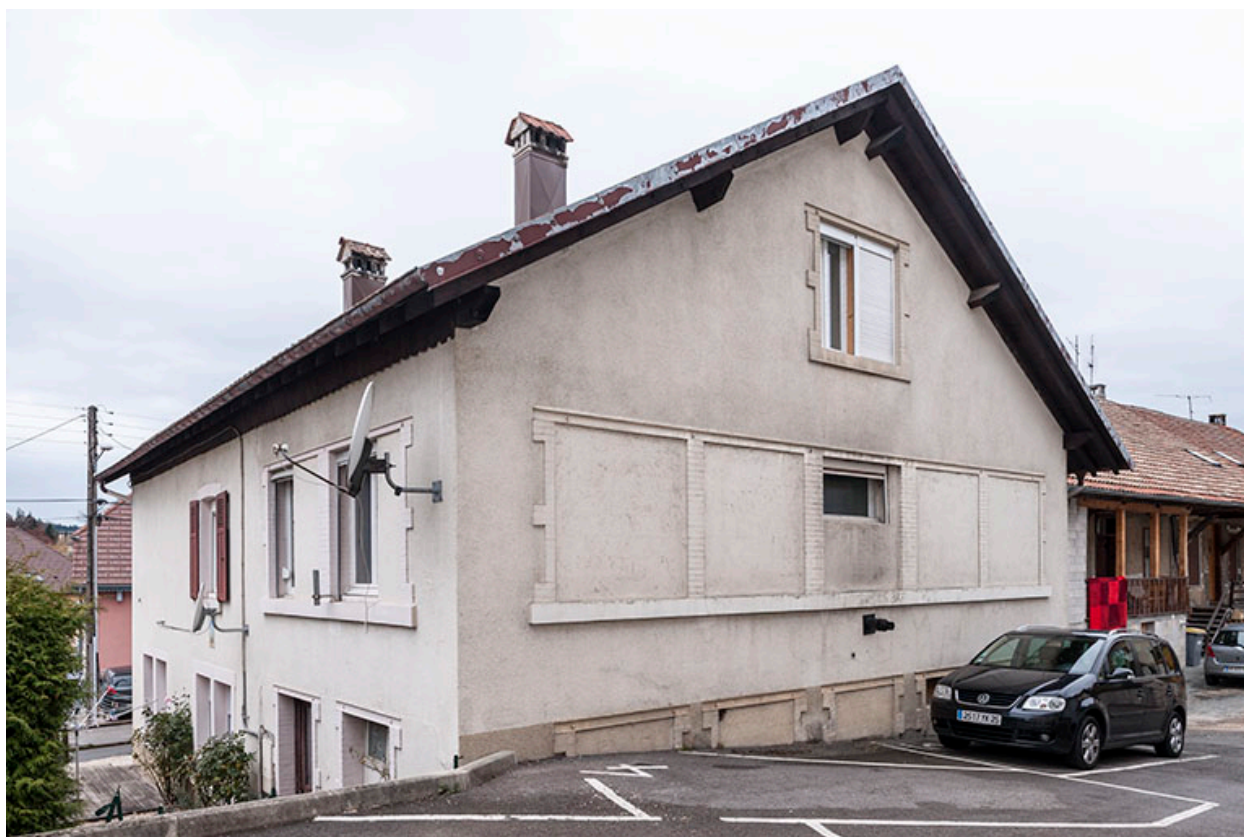
Maison : façades postérieure et latérale droite.
