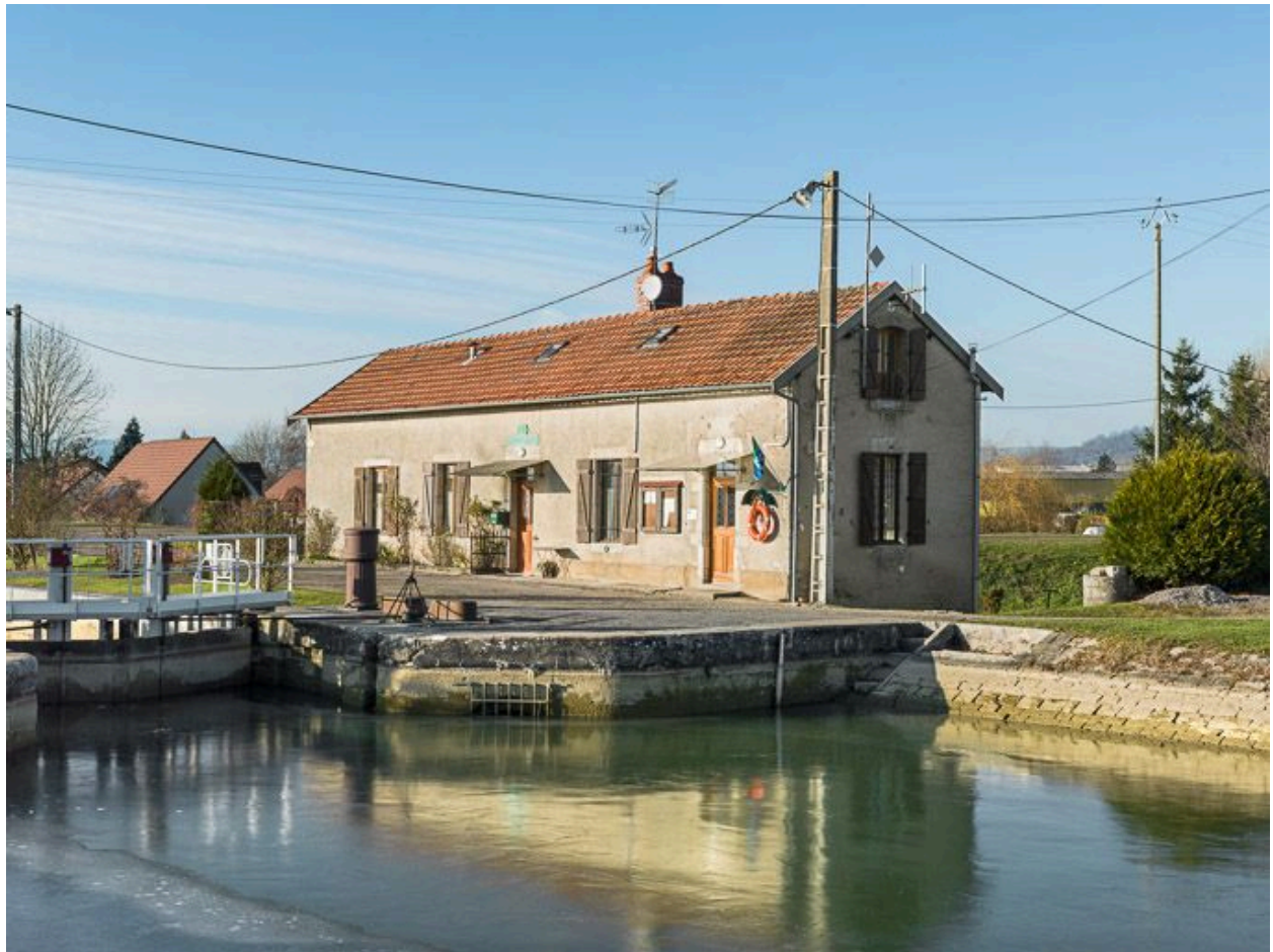
Vue de 3/4 de la maison éclusière.
