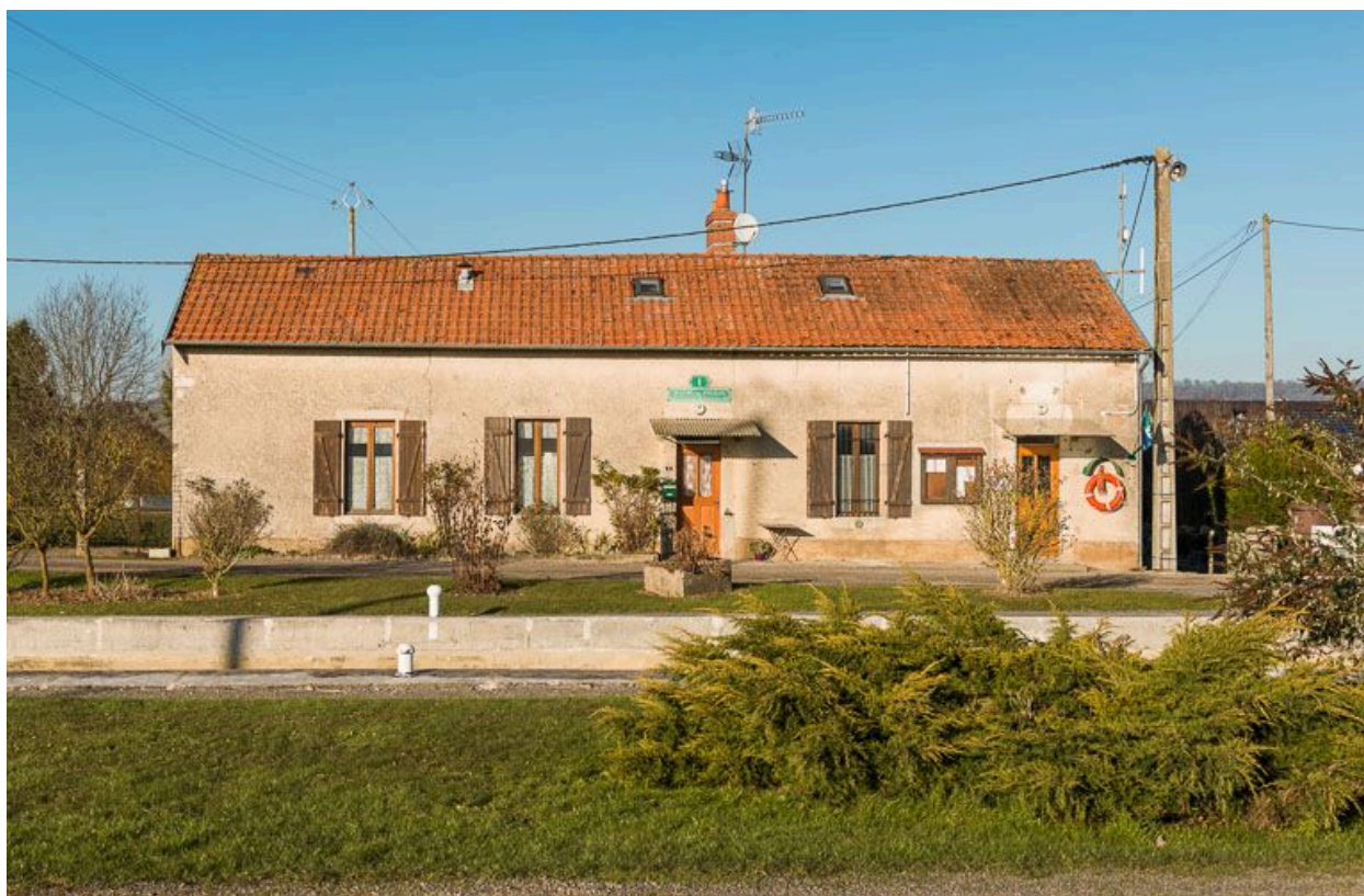
Vue de face de la maison éclusière.
