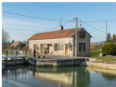
Vue de 3/4 de la maison éclusière. Phot. Pierre-Marie Barbe-Richaud IVR26_20132101040NUC4AQ
