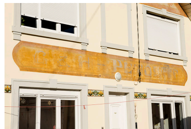
Pignon est. Détail du bandeau peint. Phot. Jérôme Mongreville IVR43_20172501148NUC4A
