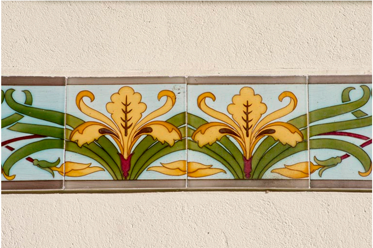
Pignon est de l'atelier. Détail des faïences.
