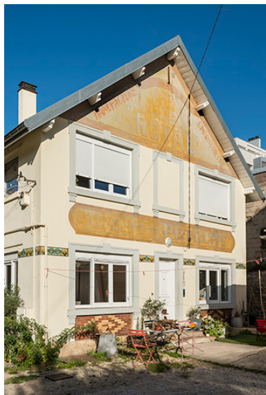
Pignon est de l'atelier. Phot. Jérôme Mongreville IVR43_20172501147NUC4A
