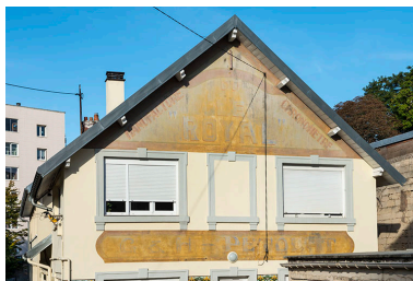
Atelier de fabrication. Partie supérieure du pignon. Phot. Jérôme Mongreville IVR43_20172501151NUC4A
