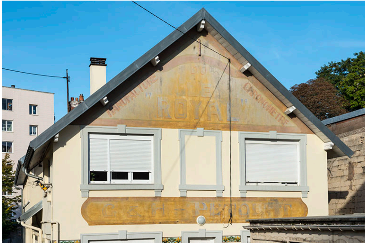
Atelier de fabrication. Partie supérieure du pignon.
