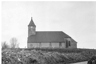
Façade latérale droite. Phot. Guy Forestier IVR43_19743901013Z
