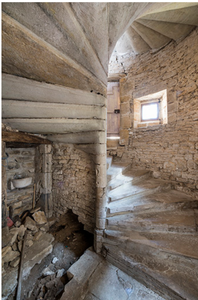
L'escalier, vue depuis le rez-de-chaussée.
