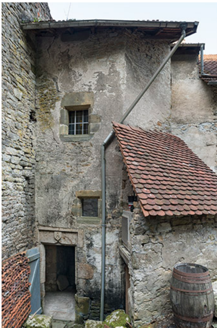
Tour comprenant l'escalier, côté cour.
