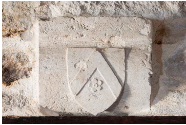
Blason situé au premier étage. Phot. Jérôme Mongreville IVR43_20177000838NUC4A
