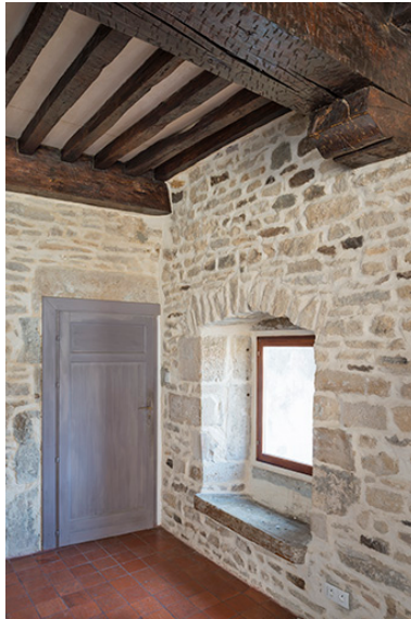
Détail sur le plafond à la française, premier étage. Phot. Jérôme Mongreville IVR43_20177000839NUC4A
