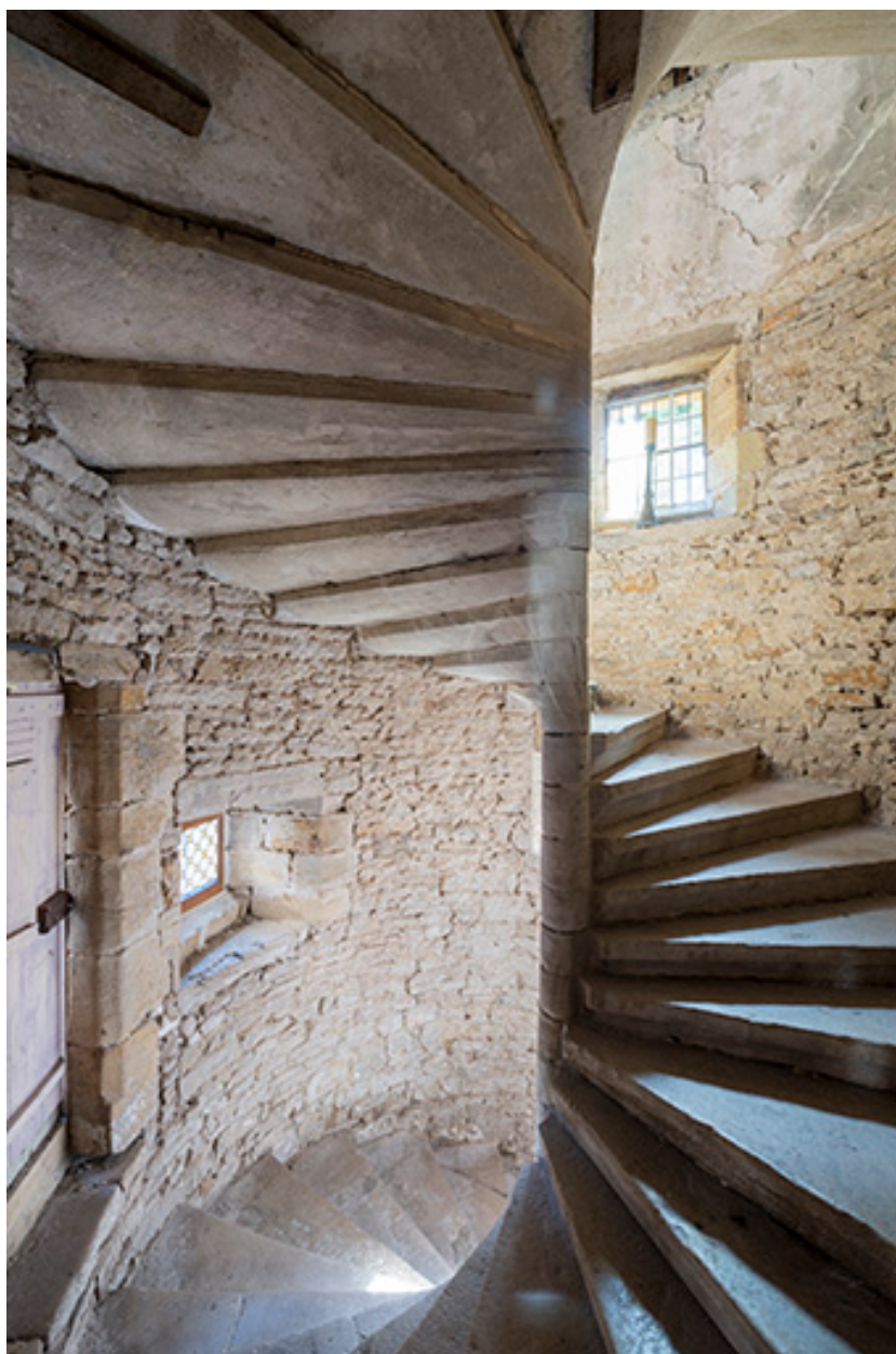
Escalier suspendu, vue depuis le premier étage.
