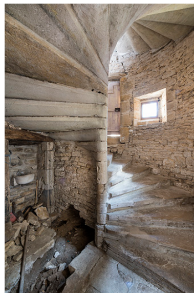
L'escalier, vue depuis le rez-de-chaussée. Phot. Jérôme Mongreville IVR43_20177000843NUC4A
