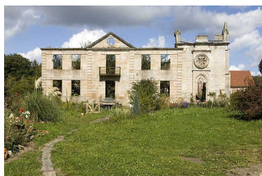
Logement patronal et chapelle. Façade antérieure. Phot. Jérôme Mongreville IVR43_20077000507NUCA
