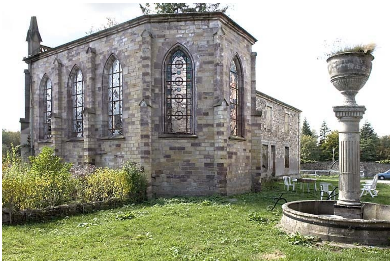
La chapelle, vue de trois quarts arrière.
