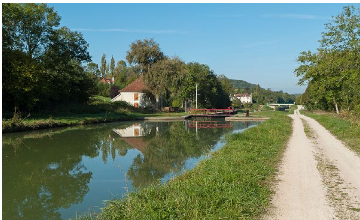
Vue du site d'écluse depuis l'amont.
