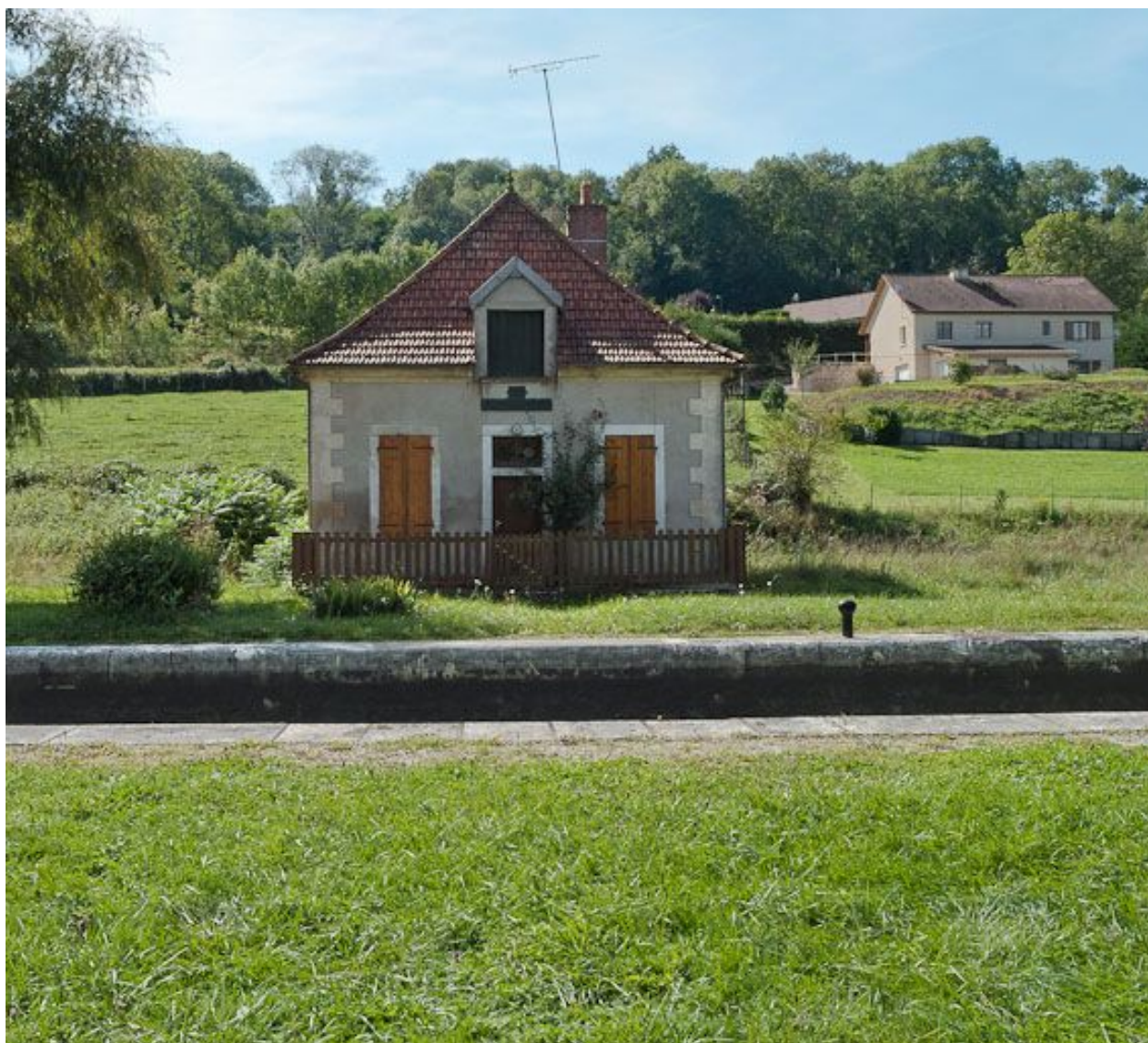
Vue de face de la maison éclusière.
