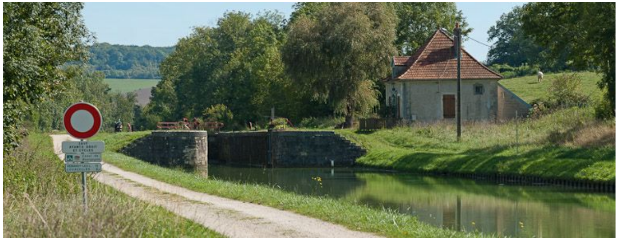
Vue du site d'écluse depuis l'amont.
