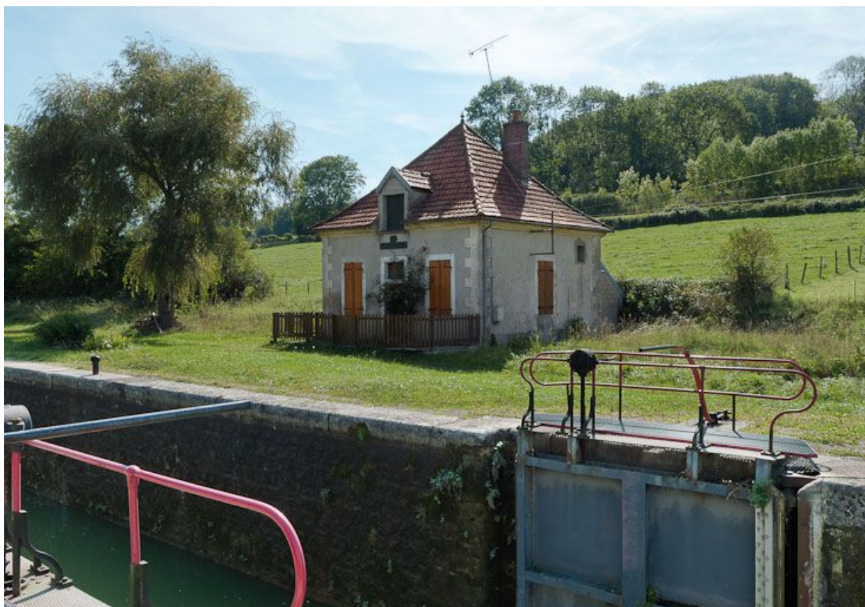
Vue d'ensemble du site d'écluse.
