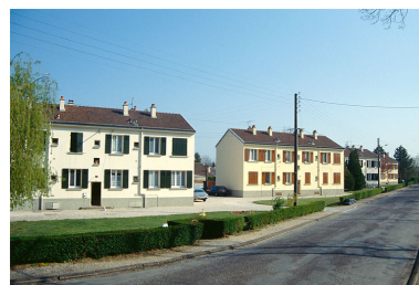
Immeubles semblables, rue des Verneaux. Phot. Laurent Poupard IVR43_19893900564ZA
