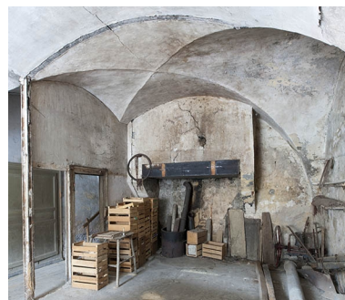
La cuisine et sa cheminée. Phot. Jérôme Mongreville IVR43_20127000454NUC4A
