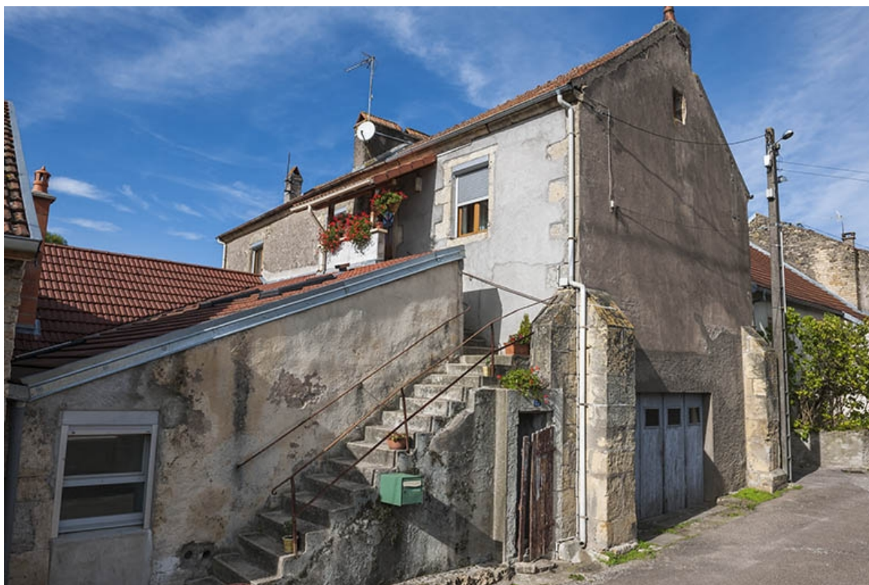
Vue générale depuis la rue des Ruaux.
