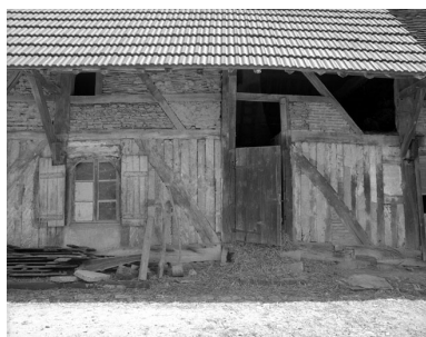
Bâtiment d'habitation : détail de la façade antérieure. Phot. Yves Sancey IVR43_19903901113X
