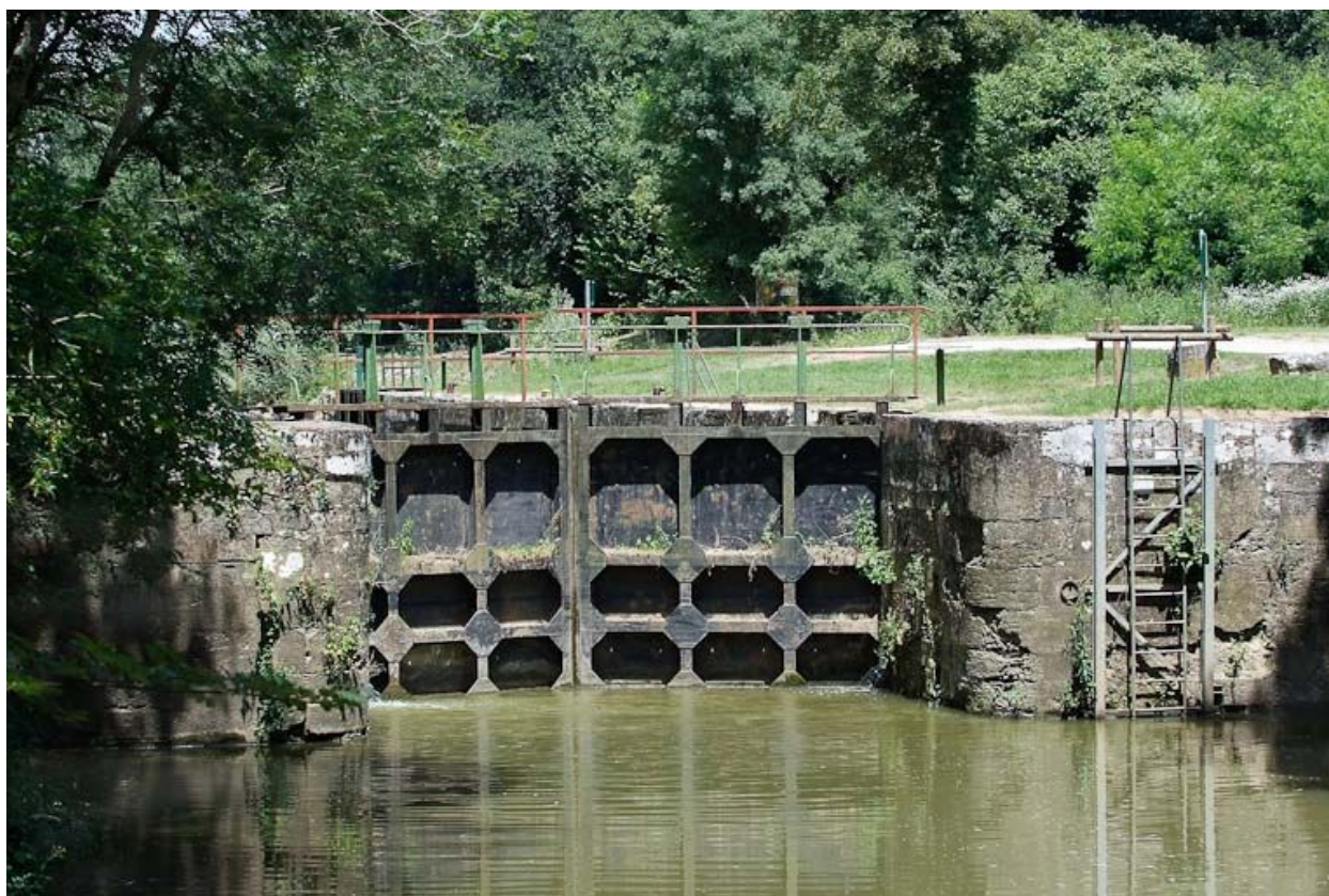
Tête aval du sas de l'écluse. Derrière, emplacement vide de la maison éclusière.
