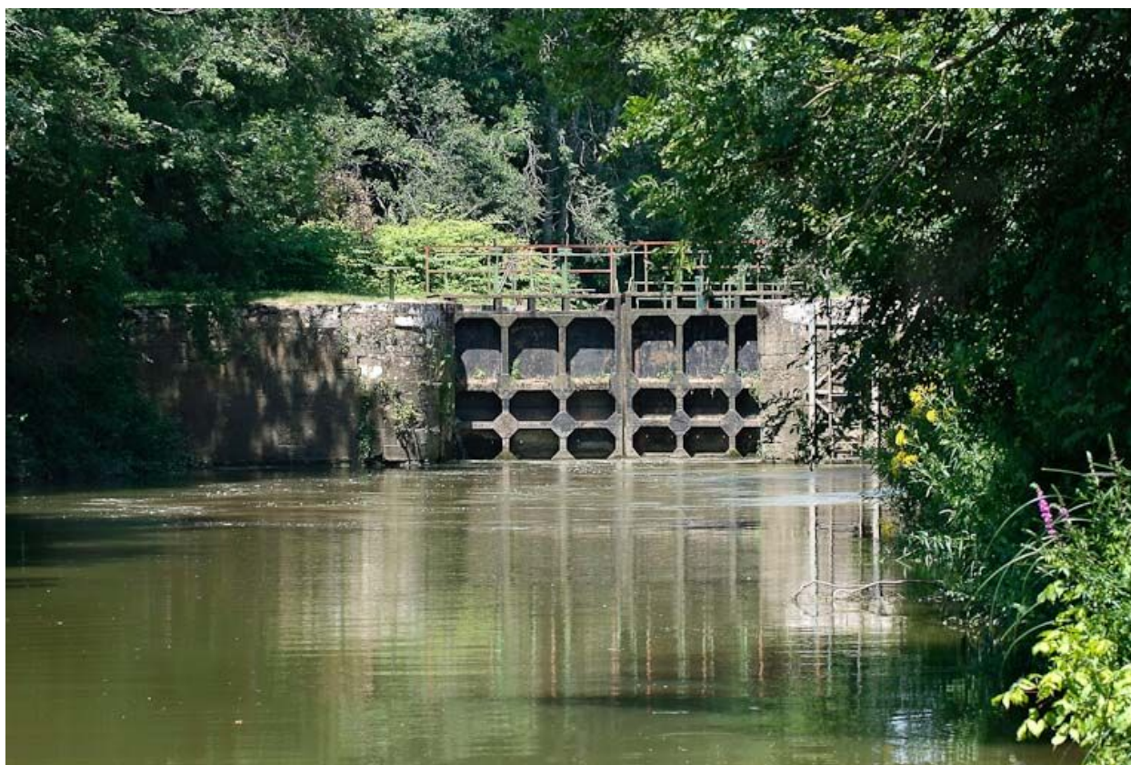
Le sas de l'écluse, vu d'aval.
