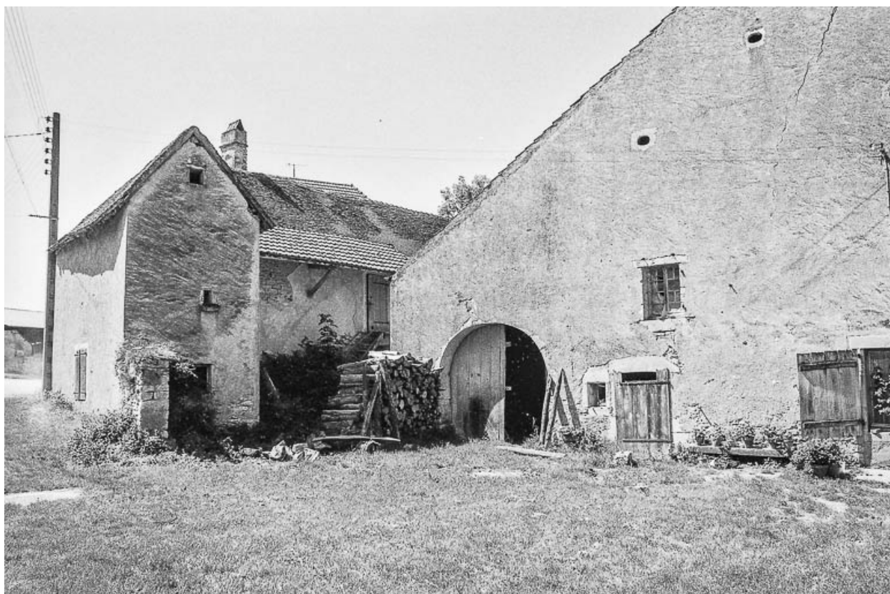
Vue de trois quarts gauche du bâtiment.
