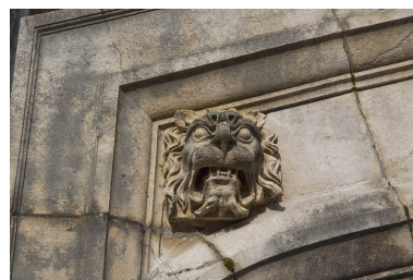
Portail d'entrée, partie supérieure : détail du mufle de lion gauche. Phot. Yves Sancey IVR43_20112501823NUC2A
