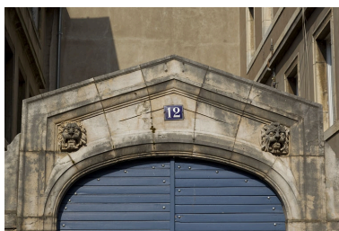
Portail d'entrée : détail de la partie supérieure. Phot. Yves Sancey IVR43_20112501822NUC2A
