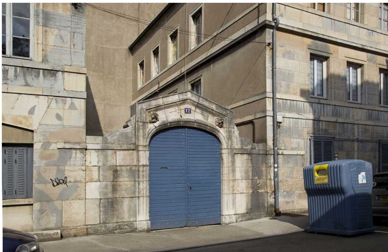
Vue du portail d'entrée et du logis secondaire, depuis la rue : de trois quarts gauche.
