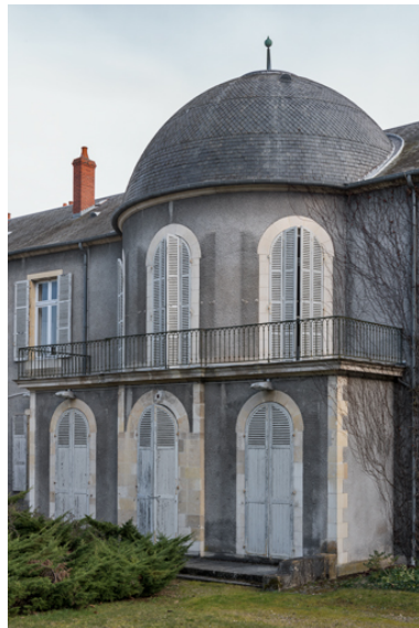
Façade sur le jardin, avant-corps. Phot. Pierre-Marie Barbe-Richaud IVR26_20235800018NUC4A
