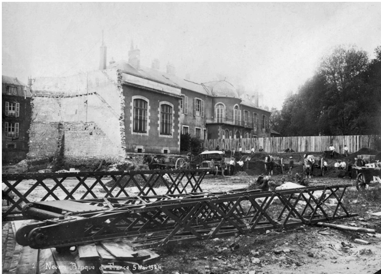
Chantier de construction (5 mai 1924).
