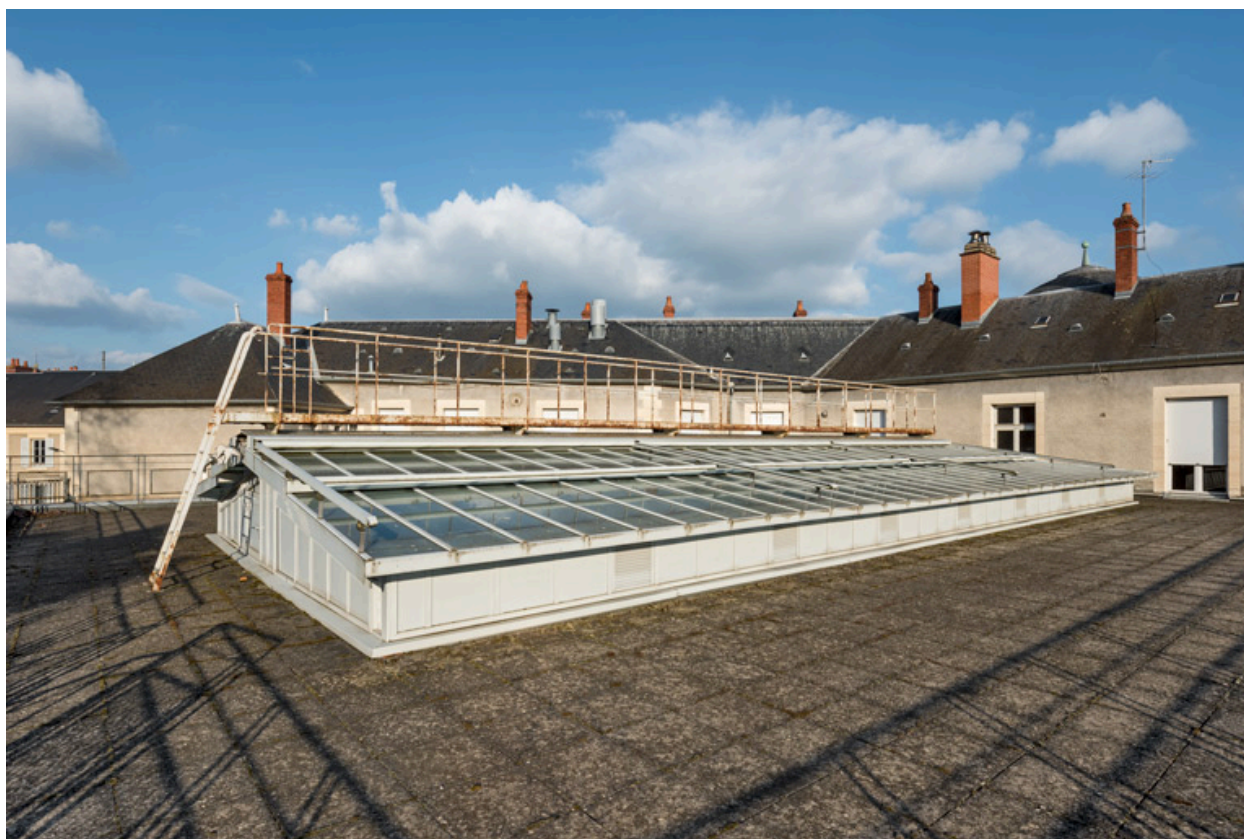
Verrière en toiture du hall du public.
