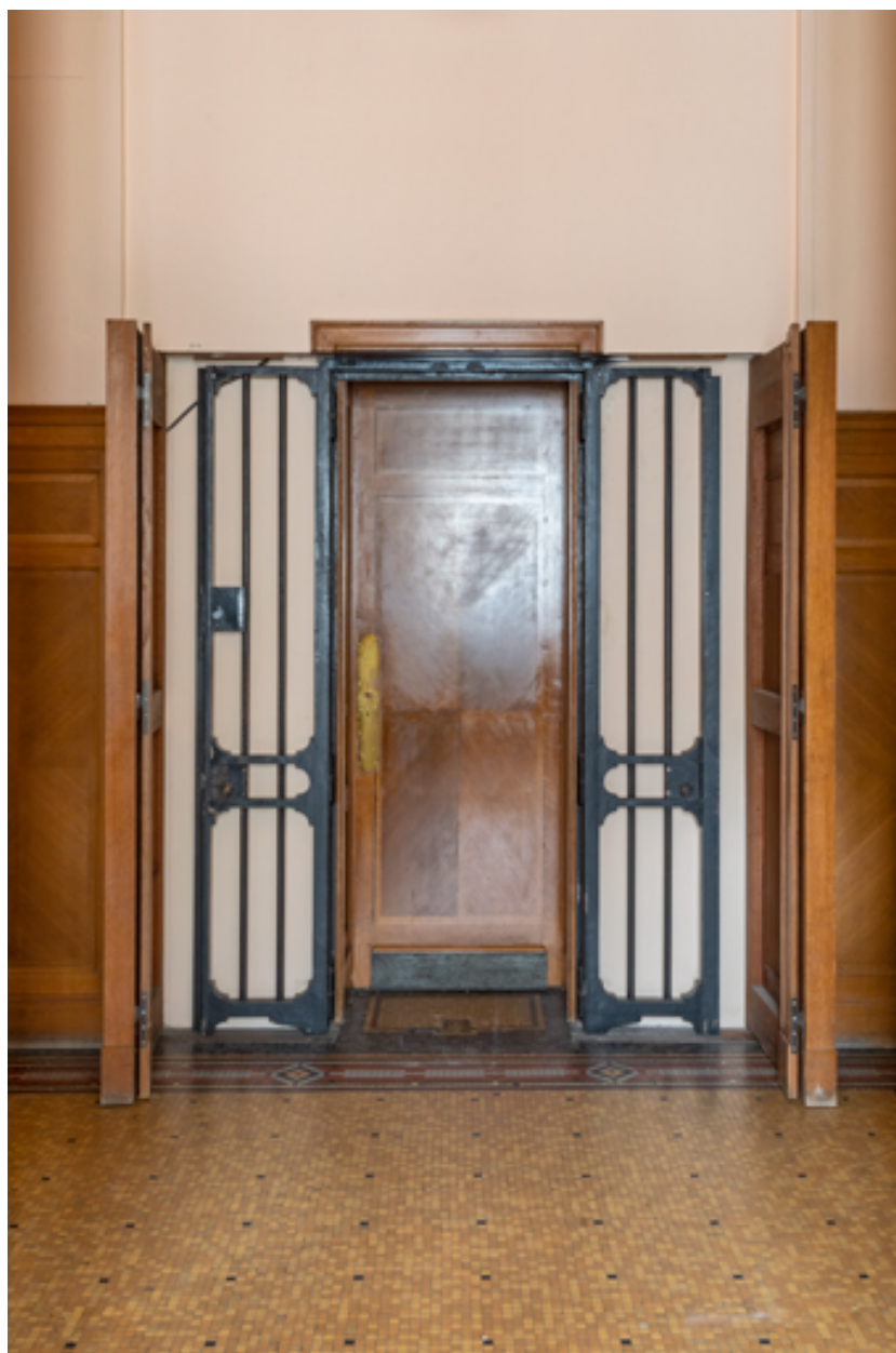
Rez-de-chaussée, grille séparant l'antichambre de la salle du conseil et le bureau du contrôleur.
