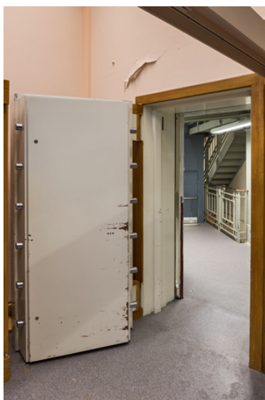
Rez-de-chaussée, caisse auxiliaire, porte (vue depuis l'extérieur). Phot. Pierre-Marie Barbe-Richaud IVR26_20235800070NUC4A
