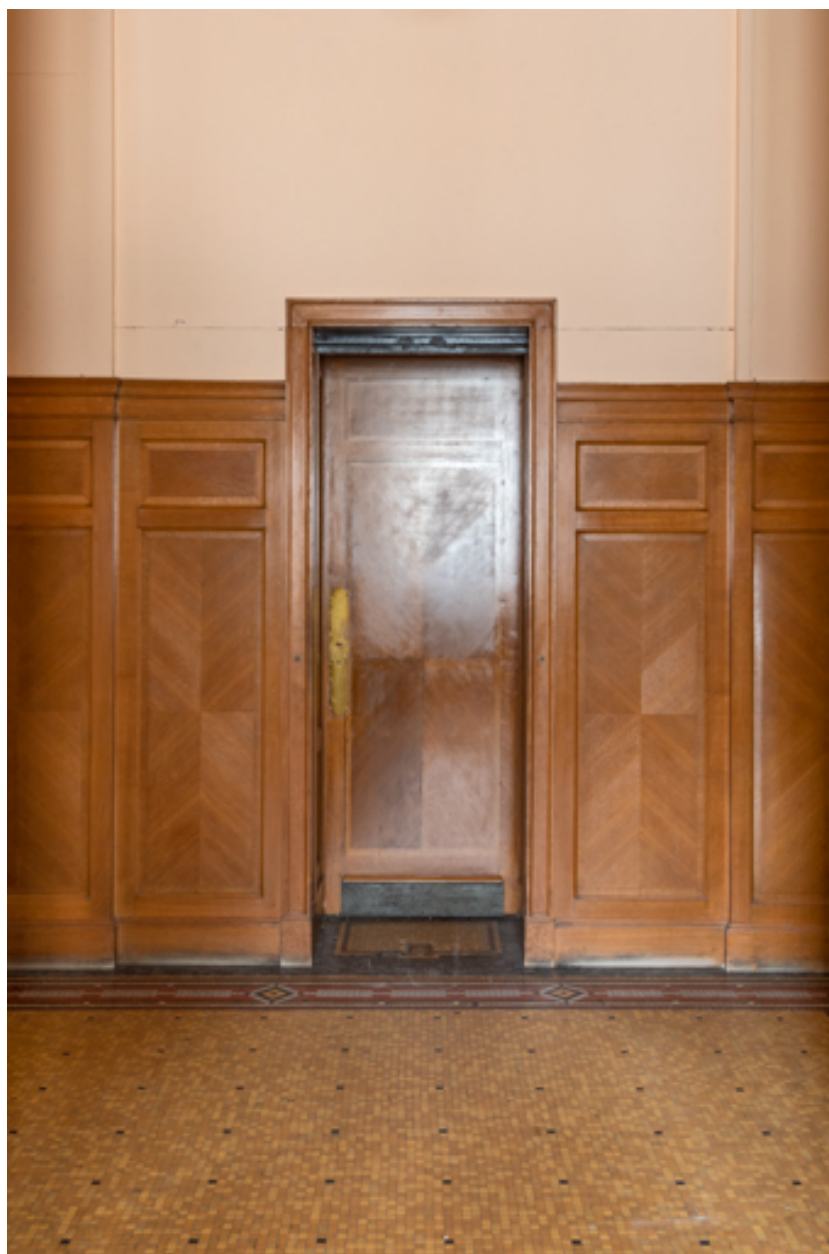
Rez-de-chaussée, grille séparant l'antichambre de la salle du conseil et le bureau du contrôleur.
