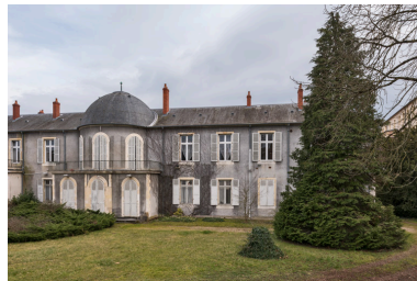
Façade sur le jardin, partie ouest. Phot. Pierre-Marie Barbe-Richaud IVR26_20235800015NUC4A
