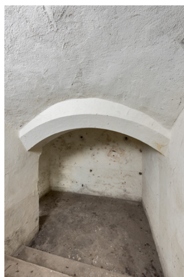
Salle du sous-sol, vestige d'une porte de cave. Phot. Pierre-Marie Barbe-Richaud IVR26_20235800035NUC4A
