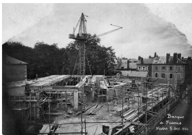
Chantier de construction (5 septembre 1924).
