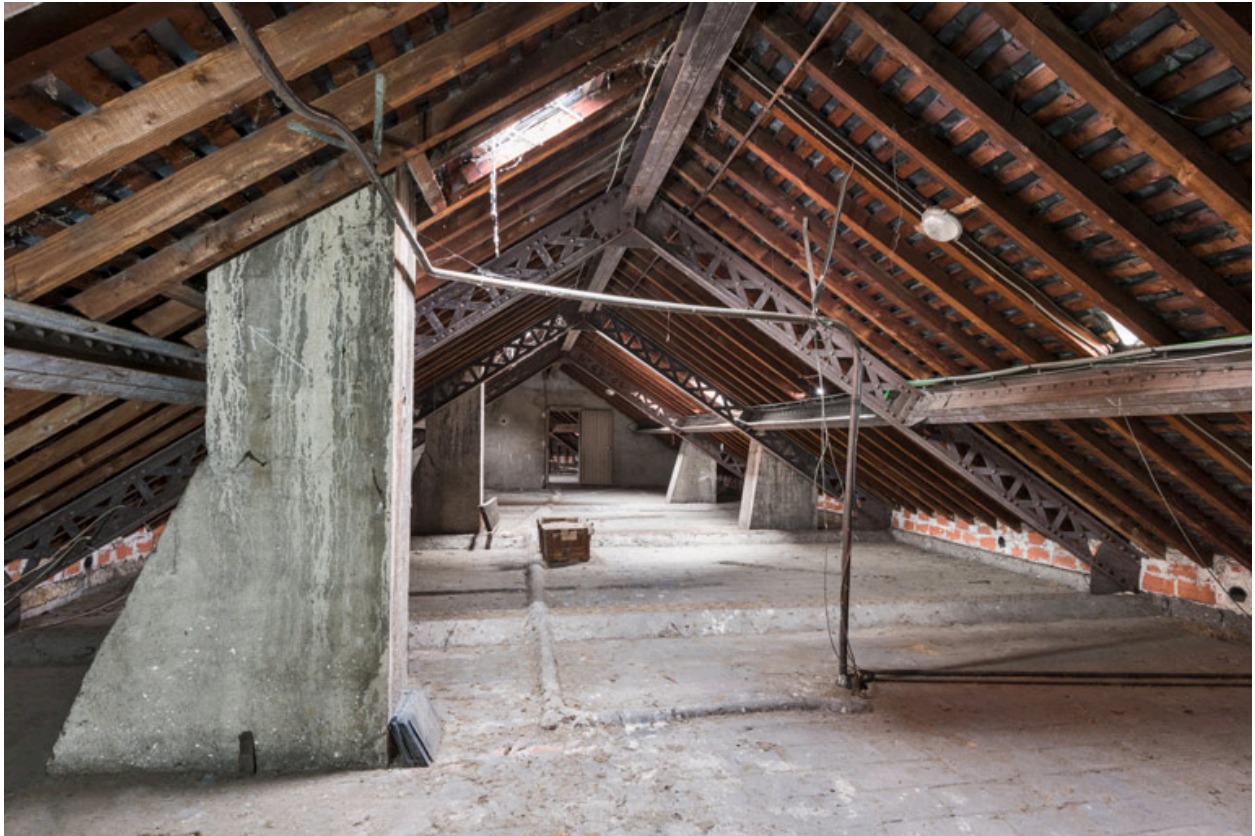
Charpente métallique.
