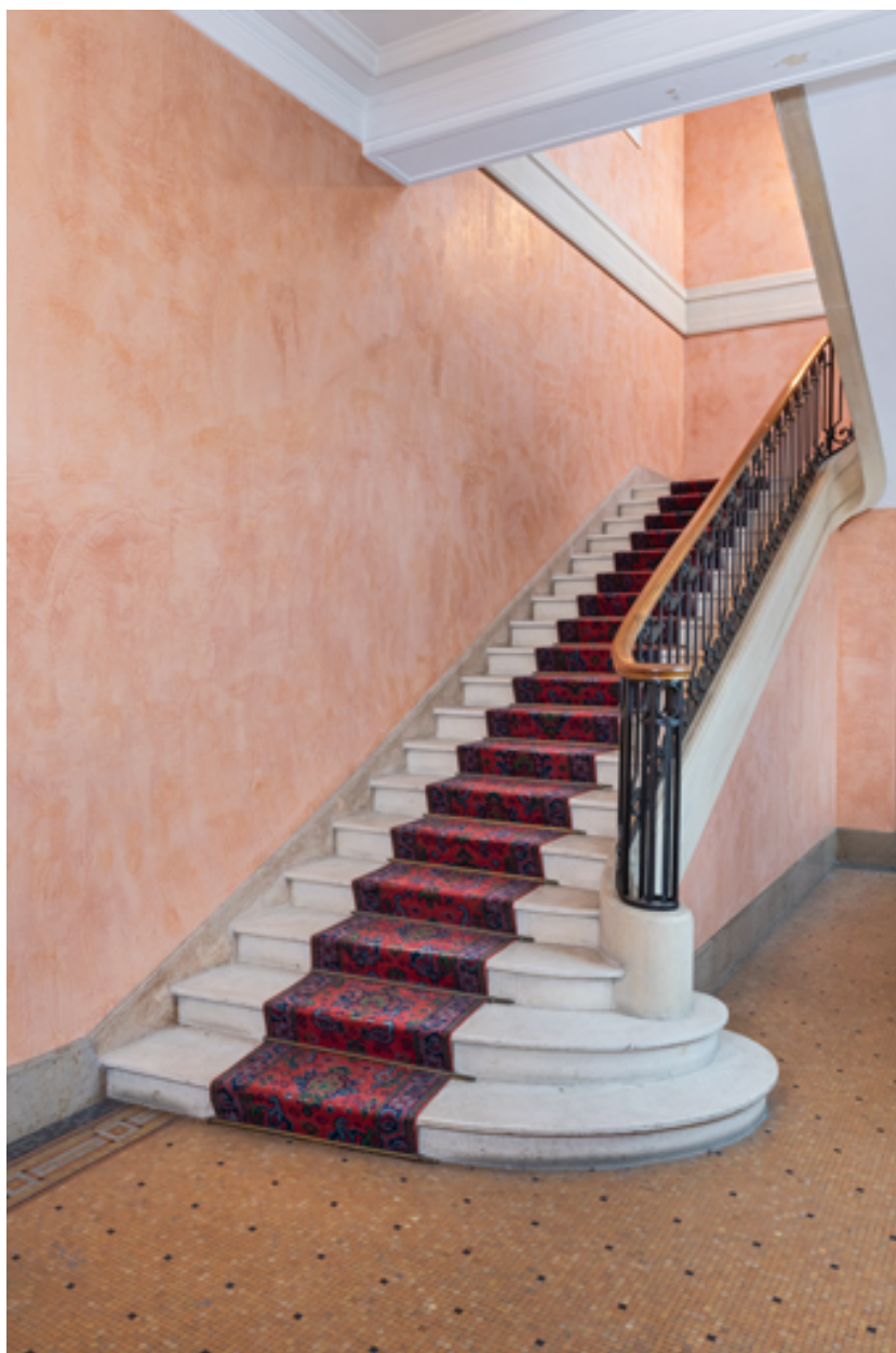
Rez-de-chaussée, vestibule du directeur, escalier.
