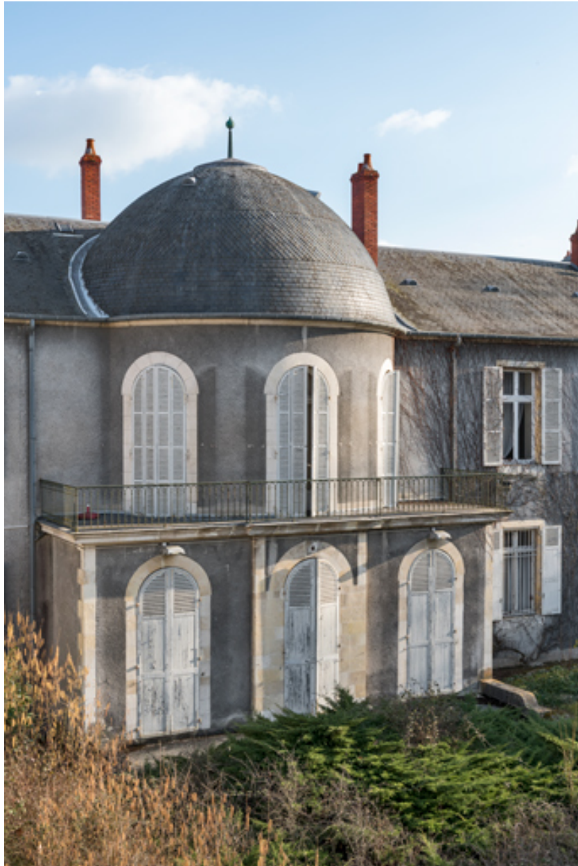
Façade sur le jardin, avant-corps.
