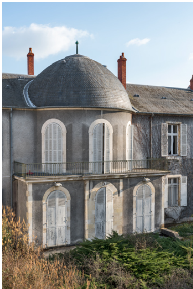
Façade sur le jardin, avant-corps. Phot. Pierre-Marie Barbe-Richaud IVR26_20235800024NUC4A
