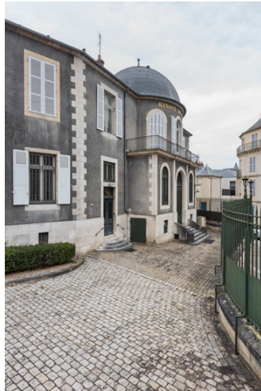
Entrée principale du public. Phot. Pierre-Marie Barbe-Richaud IVR26_20235800012NUC4A
