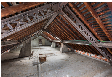
Charpente métallique. Phot. Pierre-Marie Barbe-Richaud IVR26_20235800040NUC4A
