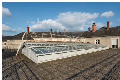
Verrière en toiture du hall du public. Phot. Pierre-Marie Barbe-Richaud IVR26_20235800026NUC4A
