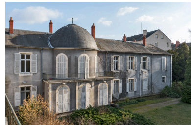
Façade sur le jardin, partie ouest. Phot. Pierre-Marie Barbe-Richaud IVR26_20235800025NUC4A
