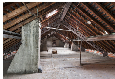
Charpente métallique. Phot. Pierre-Marie Barbe-Richaud IVR26_20235800039NUC4A
