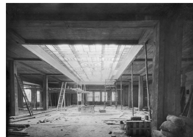
Chantier de construction (vers 1925).
