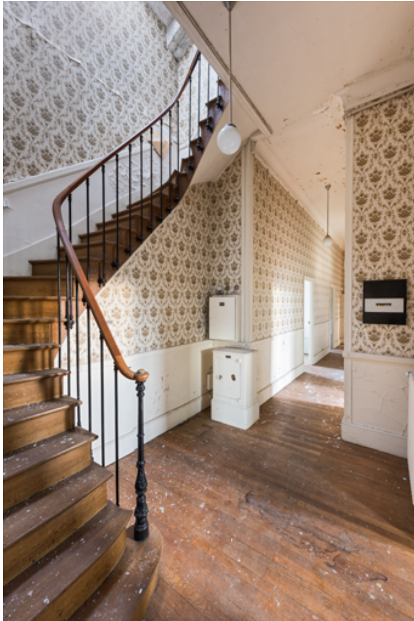
Premier étage, appartement du caissier, escalier conduisant au comble.
