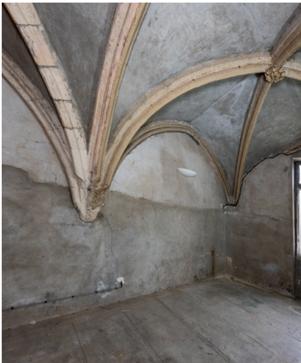
Salle du sous-sol couverte de croisées d'ogives.
