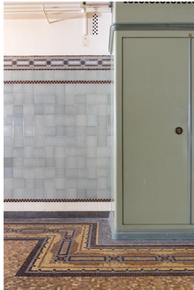
Sous-sol, salle des coffres, décor. Phot. Pierre-Marie Barbe-Richaud IVR26_20235800080NUC4A
