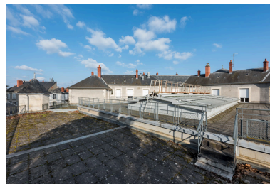
Verrière en toiture du hall du public. Phot. Pierre-Marie Barbe-Richaud IVR26_20235800023NUC4A
