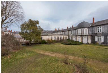
Façade sur le jardin. Phot. Pierre-Marie Barbe-Richaud IVR26_20235800017NUC4A
