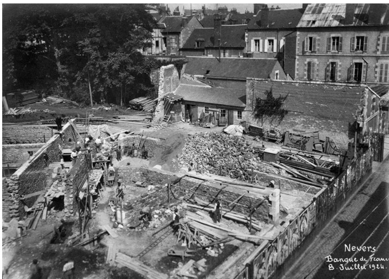
Chantier de construction (8 juillet 1924).
