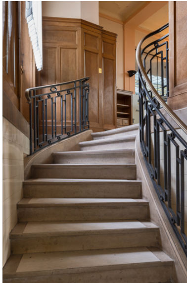
Escalier d'accès au vestiaire (au sous-sol). Phot. Pierre-Marie Barbe-Richaud IVR26_20235800107NUC2A
