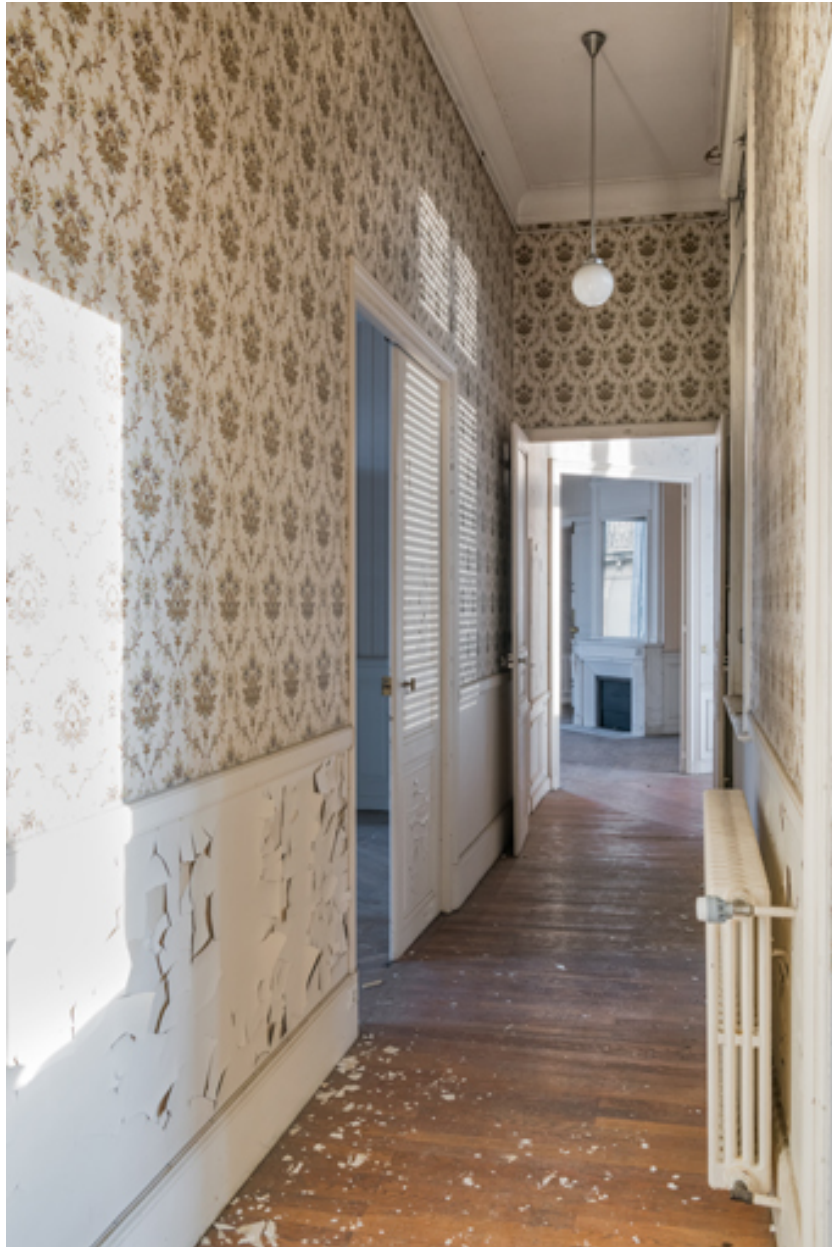
Premier étage, appartement du caissier, couloir distribuant les chambres (à gauche) et la cuisine (à droite).
