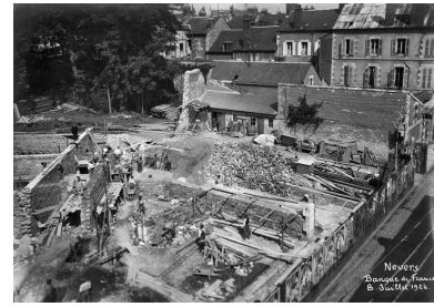
Chantier de construction (8 juillet 1924).
