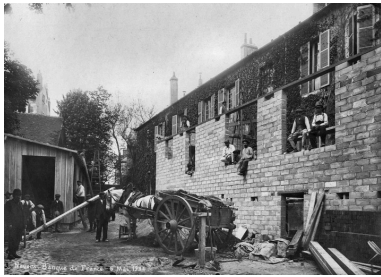
Chantier de construction (5 mai 1924).
