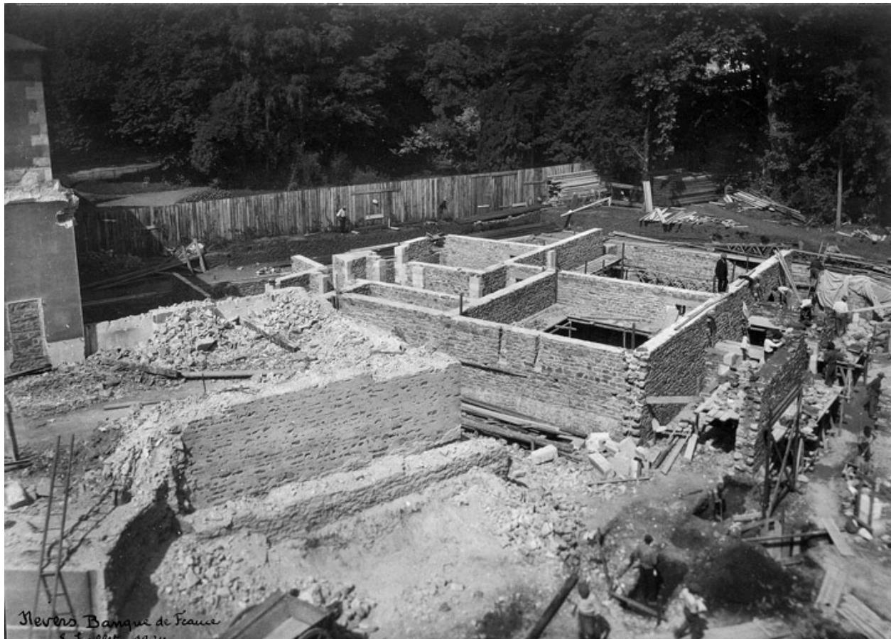
Chantier de construction (8 juin 1924).
