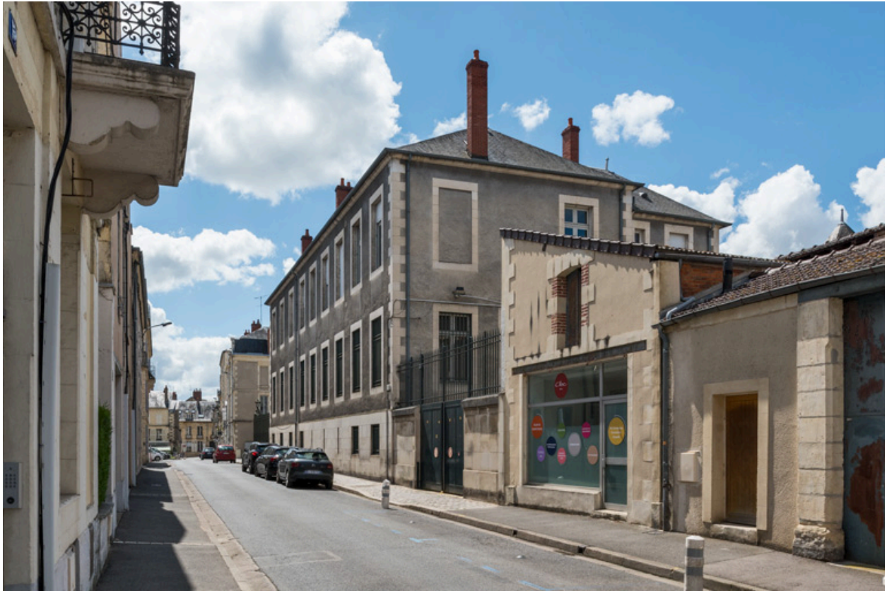
Façade sur la rue Jean Desveaux, vue depuis le nord.
