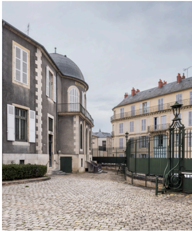
Entrée principale du public. Phot. Pierre-Marie Barbe-Richaud IVR26_20235800013NUC4A
