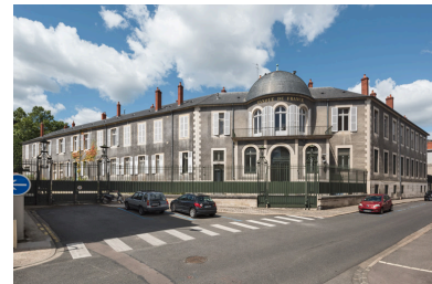
Façade sur la rue Jean Desveaux, vue depuis le sud. Phot. Pierre-Marie Barbe-Richaud IVR26_20235800164NUC4A
