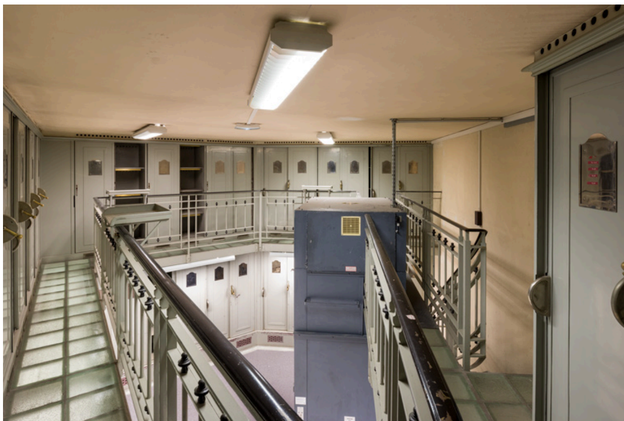
Rez-de-chaussée, caisse auxiliaire, galerie.
