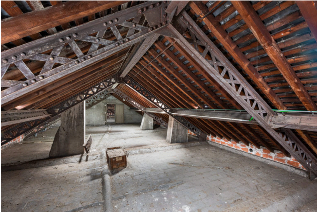
Charpente métallique.
