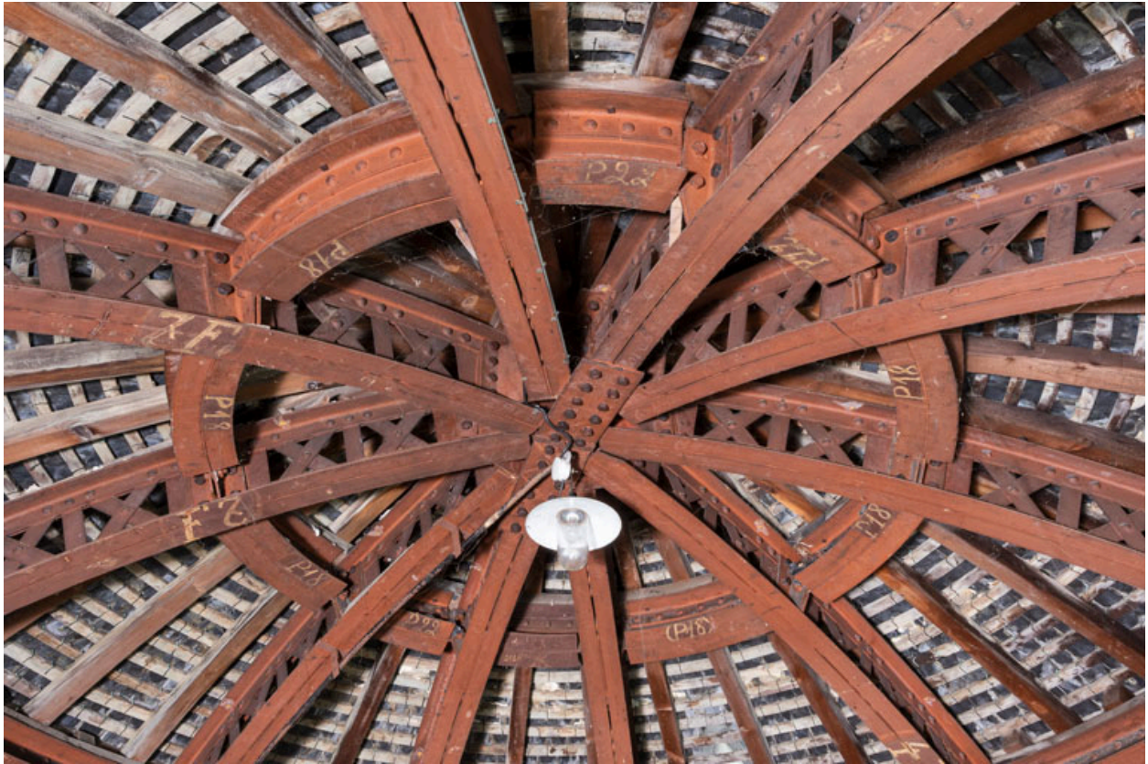
Charpente métallique.
