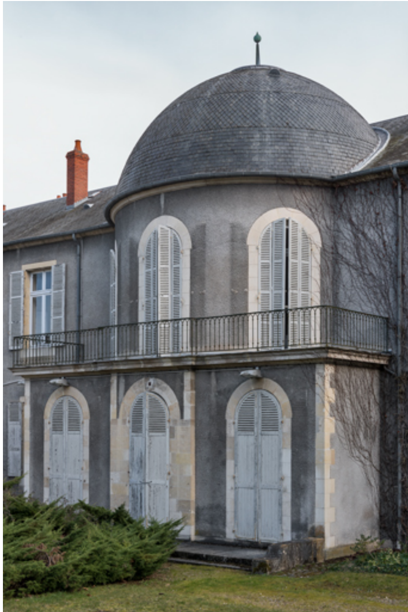
Façade sur le jardin, avant-corps.
