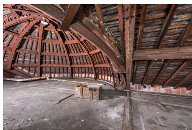
Charpente métallique. Phot. Pierre-Marie Barbe-Richaud IVR26_20235800041NUC4A
