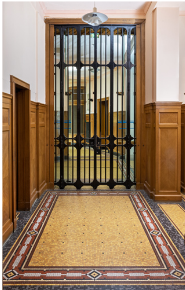
Rez-de-chaussée, grille séparant le hall du public et l'antichambre de la salle du conseil. Phot. Pierre-Marie Barbe-Richaud IVR26_20235800090NUC2A
