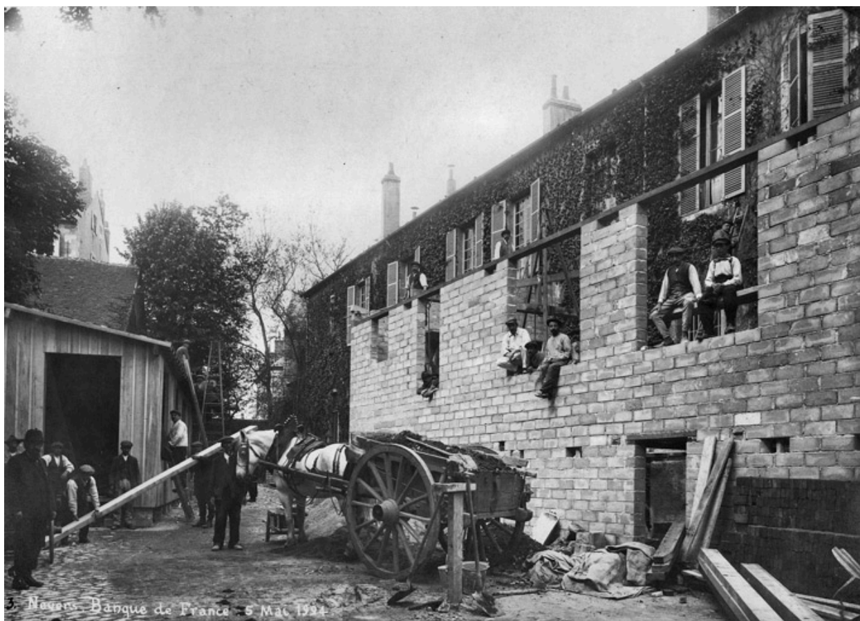
Chantier de construction (5 mai 1924).
