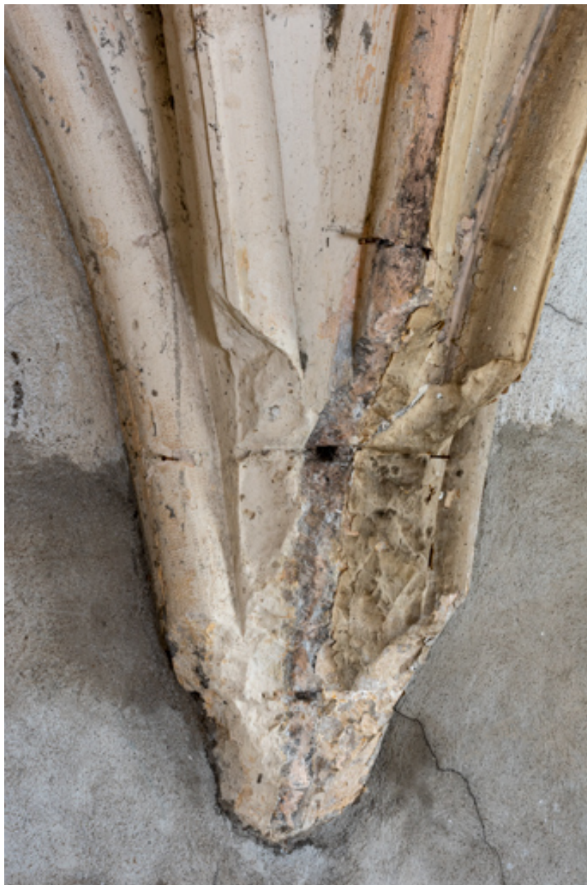
Salle du sous-sol couverte de croisées d'ogives, détail.
