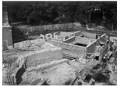
Chantier de construction (8 juin 1924).
