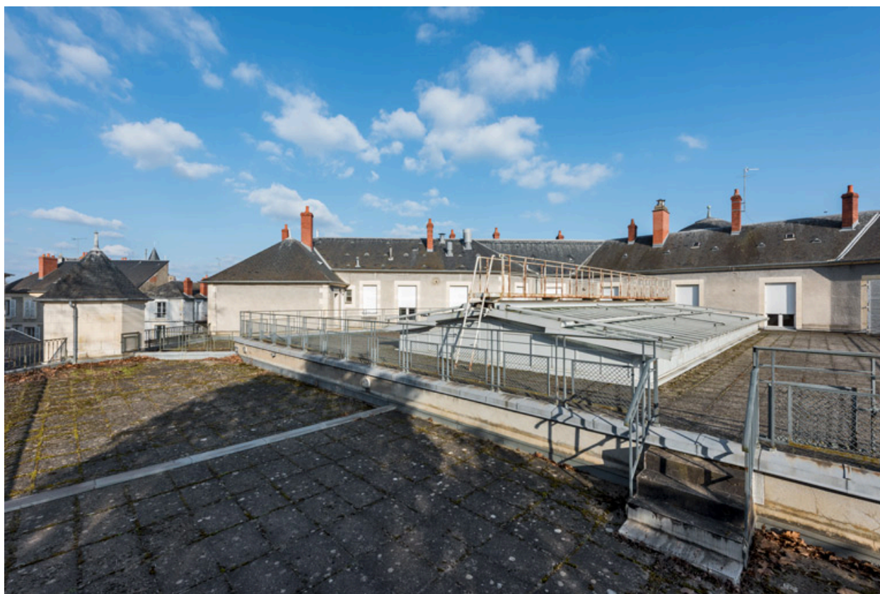
Verrière en toiture du hall du public.
