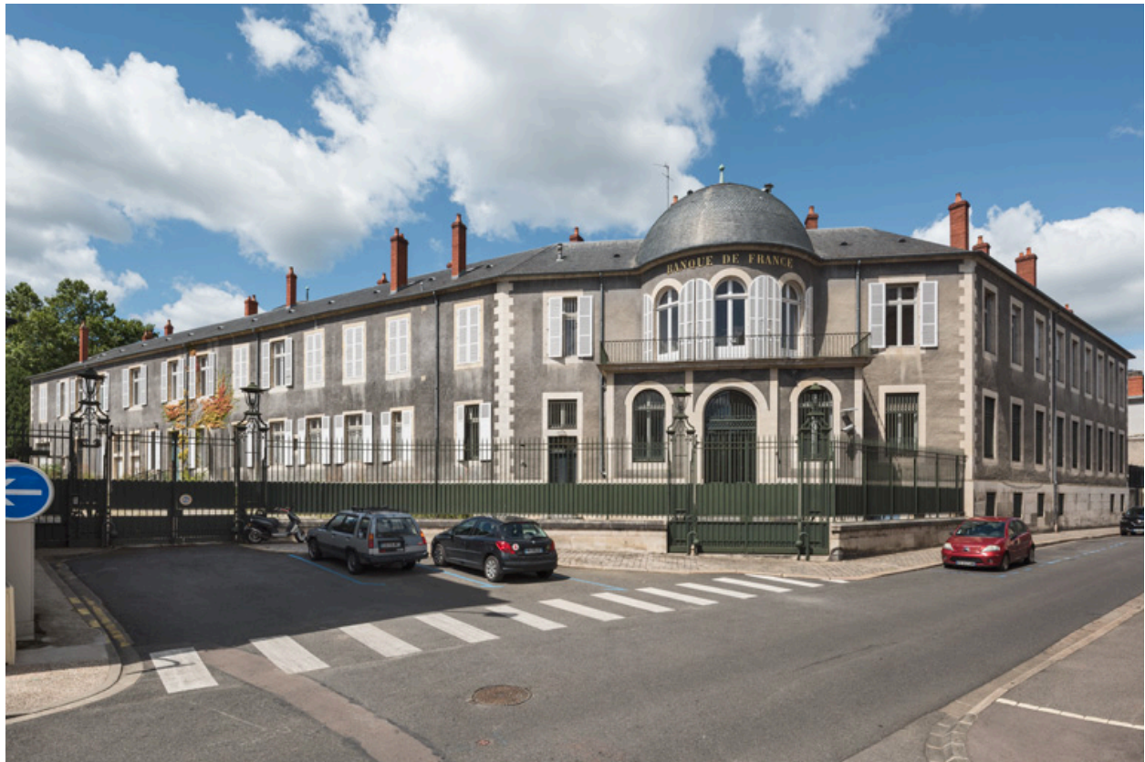
Façade sur la rue Jean Desveaux, vue depuis le sud.
