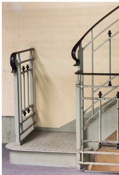
Rez-de-chaussée, caisse auxiliaire, escalier conduisant à la galerie. Phot. Pierre-Marie Barbe-Richaud IVR26_20235800073NUC4A
