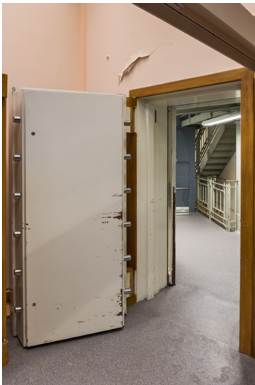
Rez-de-chaussée, caisse auxiliaire, porte (vue depuis l'extérieur).
