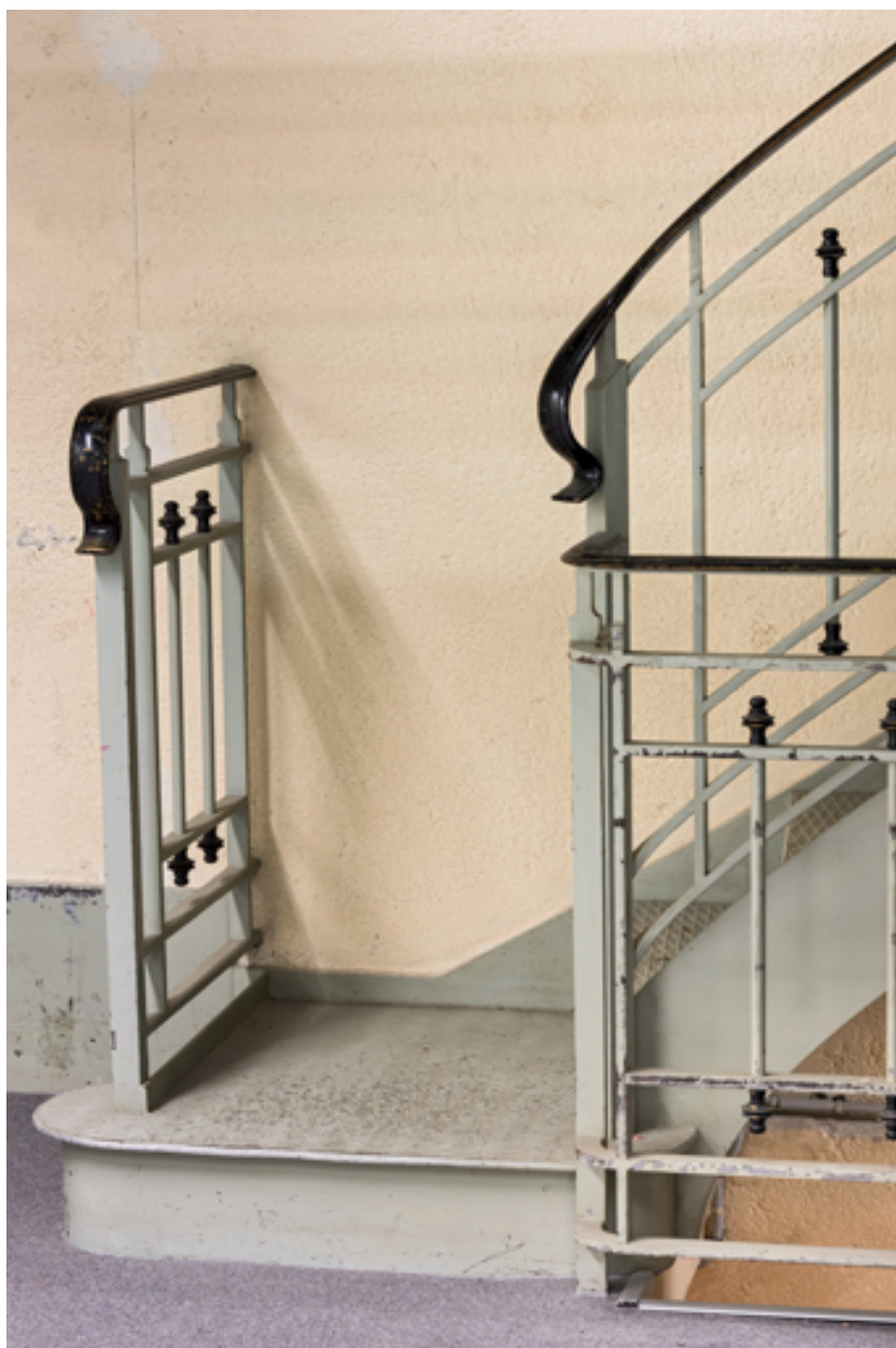
Rez-de-chaussée, caisse auxiliaire, escalier conduisant à la galerie.
