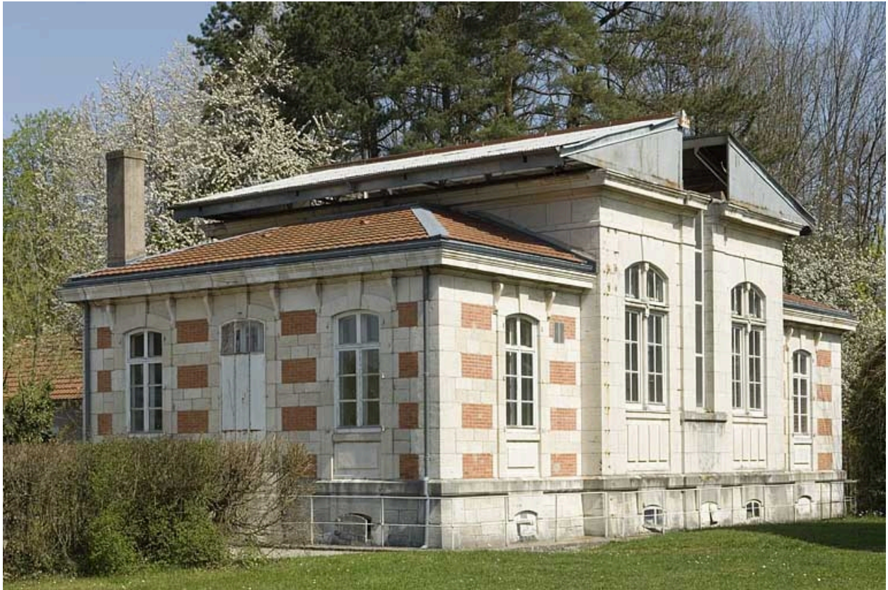
Pavillon de la méridienne, toiture ouverte.
