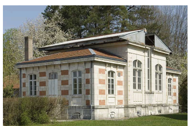
Pavillon de la méridienne, toiture ouverte. Phot. Jérôme Mongreville IVR43_20092500724NUC2A
