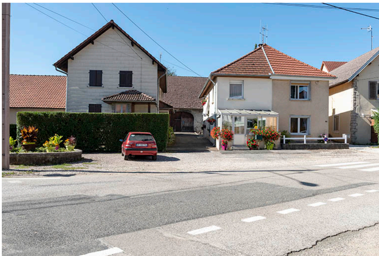
Vue d'ensemble, depuis la rue (au nord).
