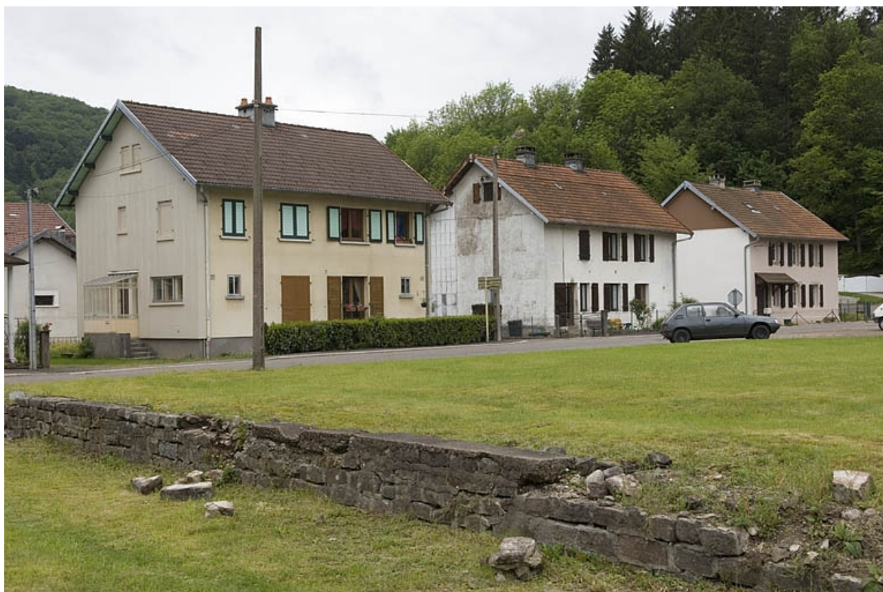
Logements ouvriers (route de Faucogney).
