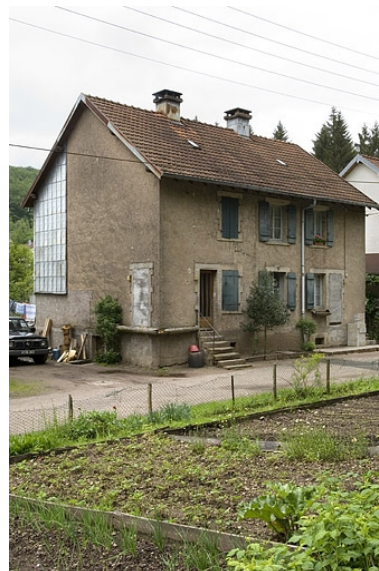
Logement ouvrier double (rue du Barrage). Phot. Jérôme Mongreville IVR43_20067000420NUCA
