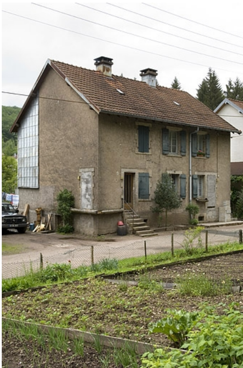
Logement ouvrier double (rue du Barrage).
