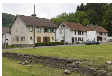
Logements ouvriers (route de Faucogney). Phot. Jérôme Mongreville IVR43_20067000413NUCA
