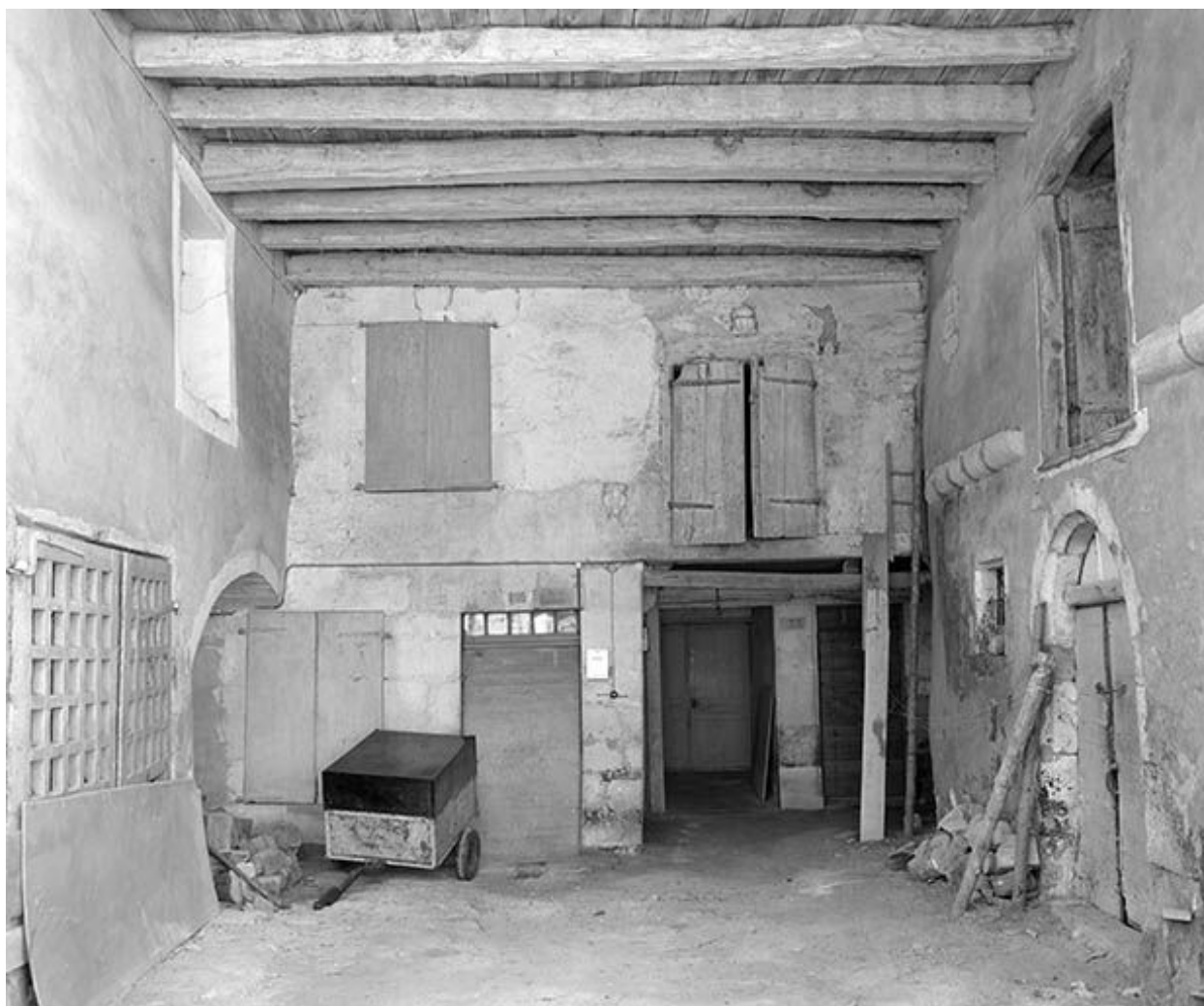
Façade antérieure : le passage plafonné.
