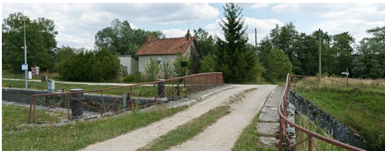
Vue d'ensemble du site d'écluse.
