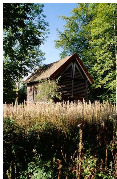
Vue de trois quarts du hangar séchoir. Phot. Yves Sancey IVR43_19973901260ZA
