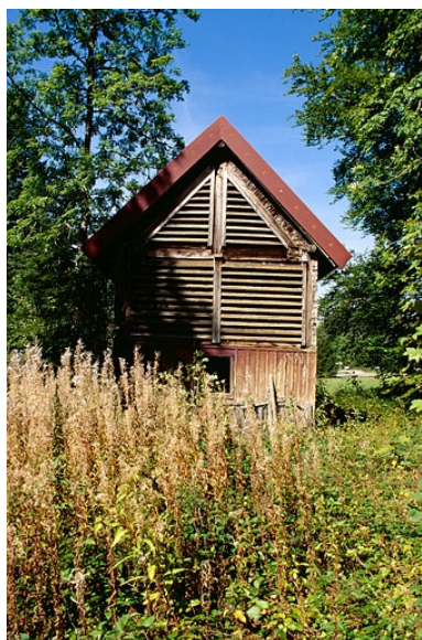
Façade sud du hangar séchoir. Phot. Yves Sancey IVR43_19973901262ZA
