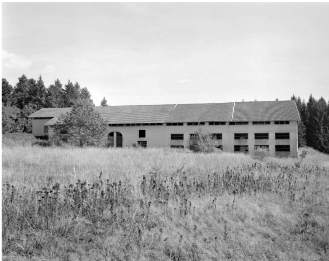
Façade postérieure du séchoir.
