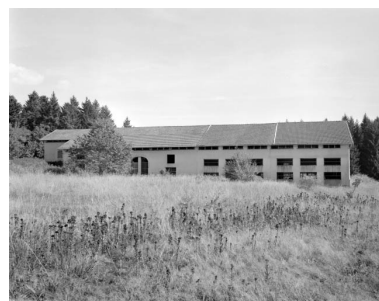
Façade postérieure du séchoir.
