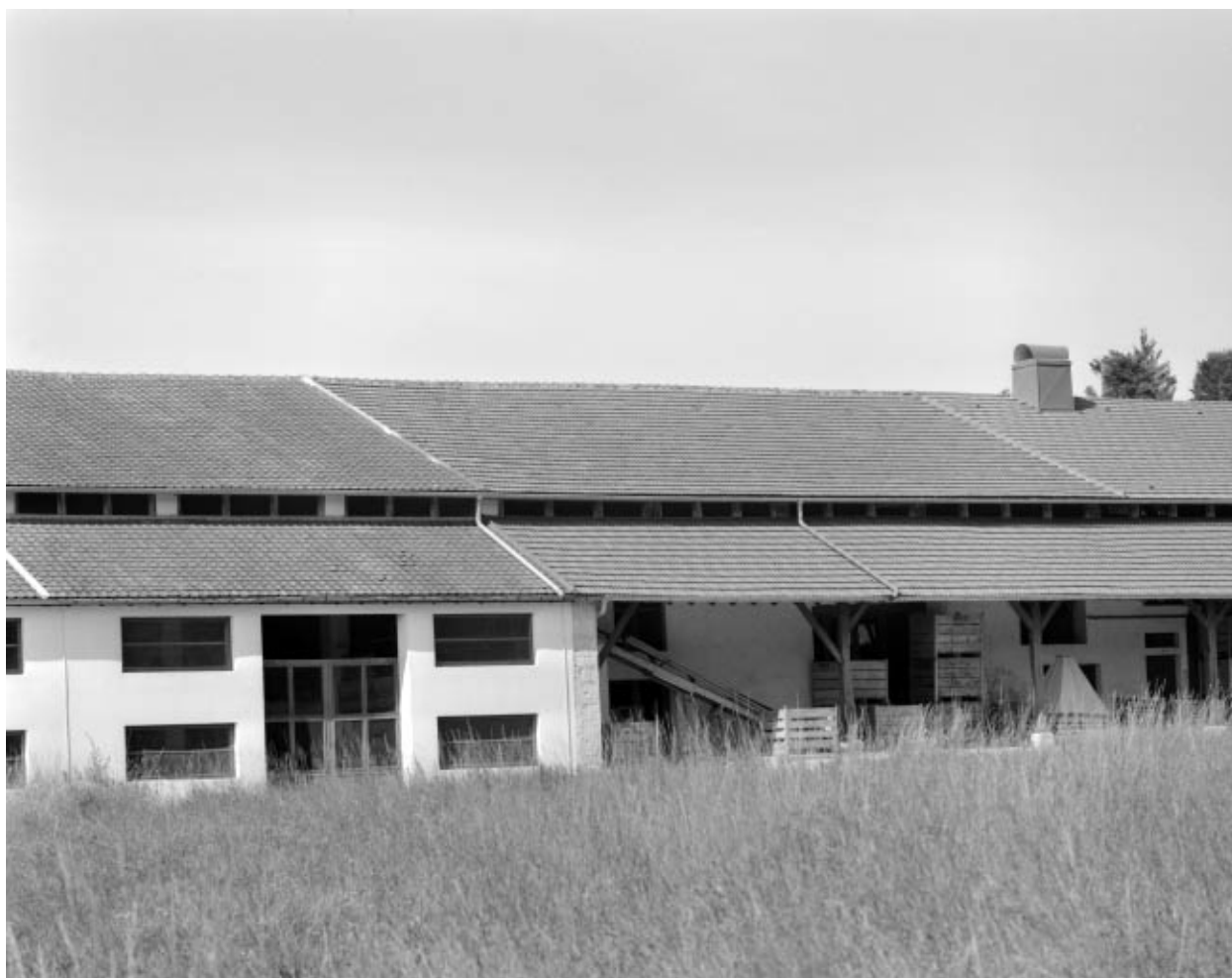
Séchoir : détail de la façade antérieure.
