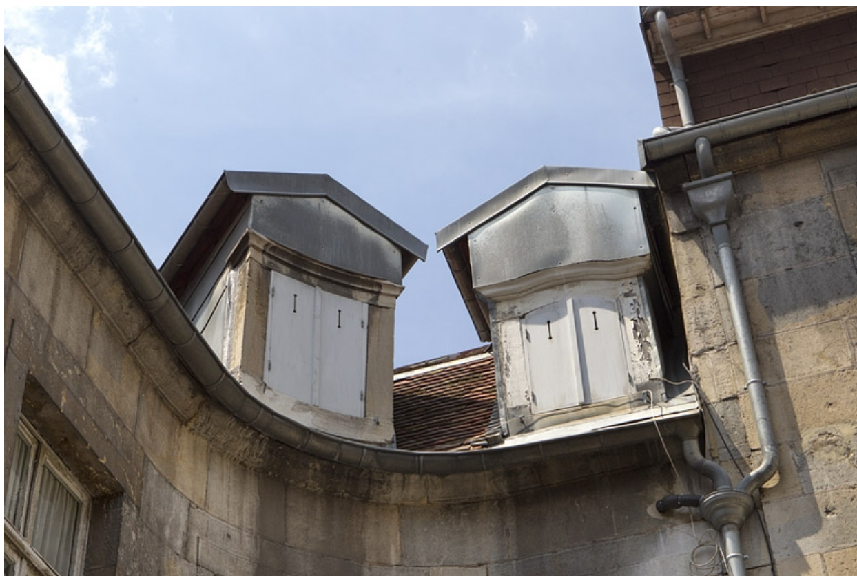
Logis principal : détail de deux lucarnes.
