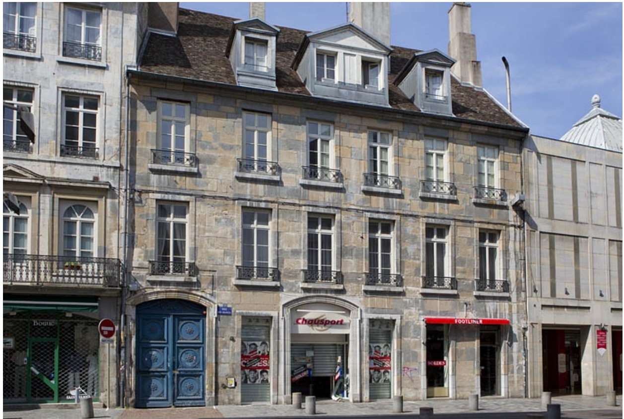
Vue d'ensemble de face depuis la rue.
