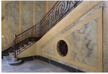
Logis principal, escalier : détail du mur d'échiffre. Phot. Yves Sancey IVR43_20102501237NUC2A
