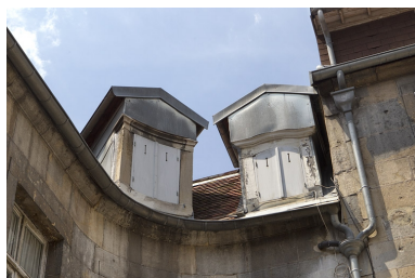
Logis principal : détail de deux lucarnes. Phot. Yves Sancey IVR43_20102501229NUC2A
