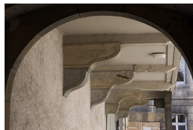
Extension en pan de bois : détail des consoles soutenant la construction. Phot. Yves Sancey IVR43_20102501231NUC2A
