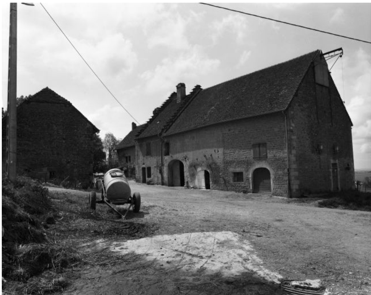
Ferme située chemin du Château : vue d'ensemble.
