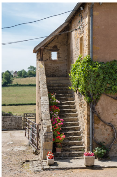
Escalier extérieur, sur la façade latérale de la maison, qui donnait accès à l'étage Phot. Pierre-Marie Barbe-Richaud IVR26_20197100160NUC4A
