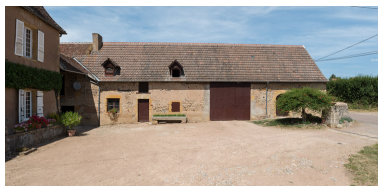
Aile de dépendance, fermant la cour au nord Phot. Pierre-Marie Barbe-Richaud IVR26_20197100153NUC4AQ
