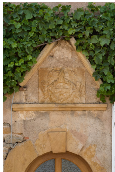
Blason avec les armoiries de la famille Guillevert, au-dessus de la porte d'entrée de la maison. La date de 1678 est gravée sur la clef de l'arc en plein cintre de l'ouverture. Phot. Pierre-Marie Barbe-Richaud IVR26_20197100161NUC4A
