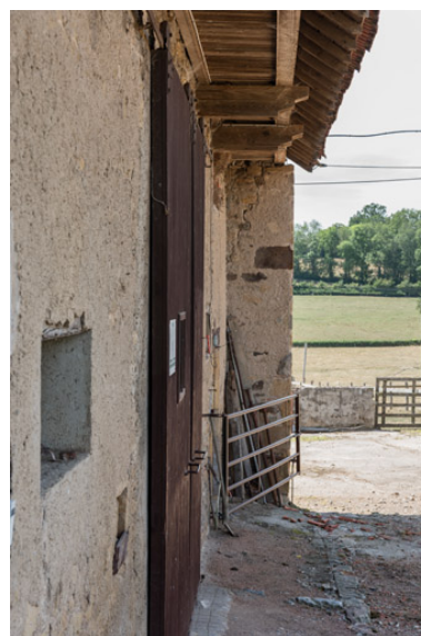
La façade de la grange est protégée par un débord de toit, soutenu par le dépassement des murs-pignons Phot. Pierre-Marie Barbe-Richaud IVR26_20197100158NUC4A
