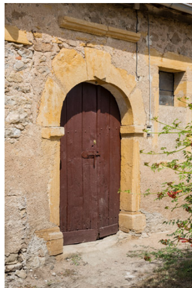
Porte de l'aile nord des dépendances, dont la clef est ornée d'une table d'attente Phot. Pierre-Marie Barbe-Richaud IVR26_20197100163NUC4A
