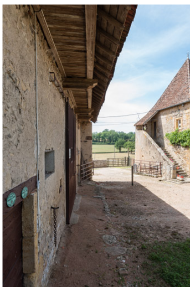
La façade de la grange est protégée par un débord de toit, soutenu par le dépassement des murs-pignons Phot. Pierre-Marie Barbe-Richaud IVR26_20197100157NUC4A
