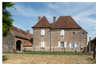
Façade postérieure de la maison Phot. Pierre-Marie Barbe-Richaud IVR26_20197100165NUC4A
