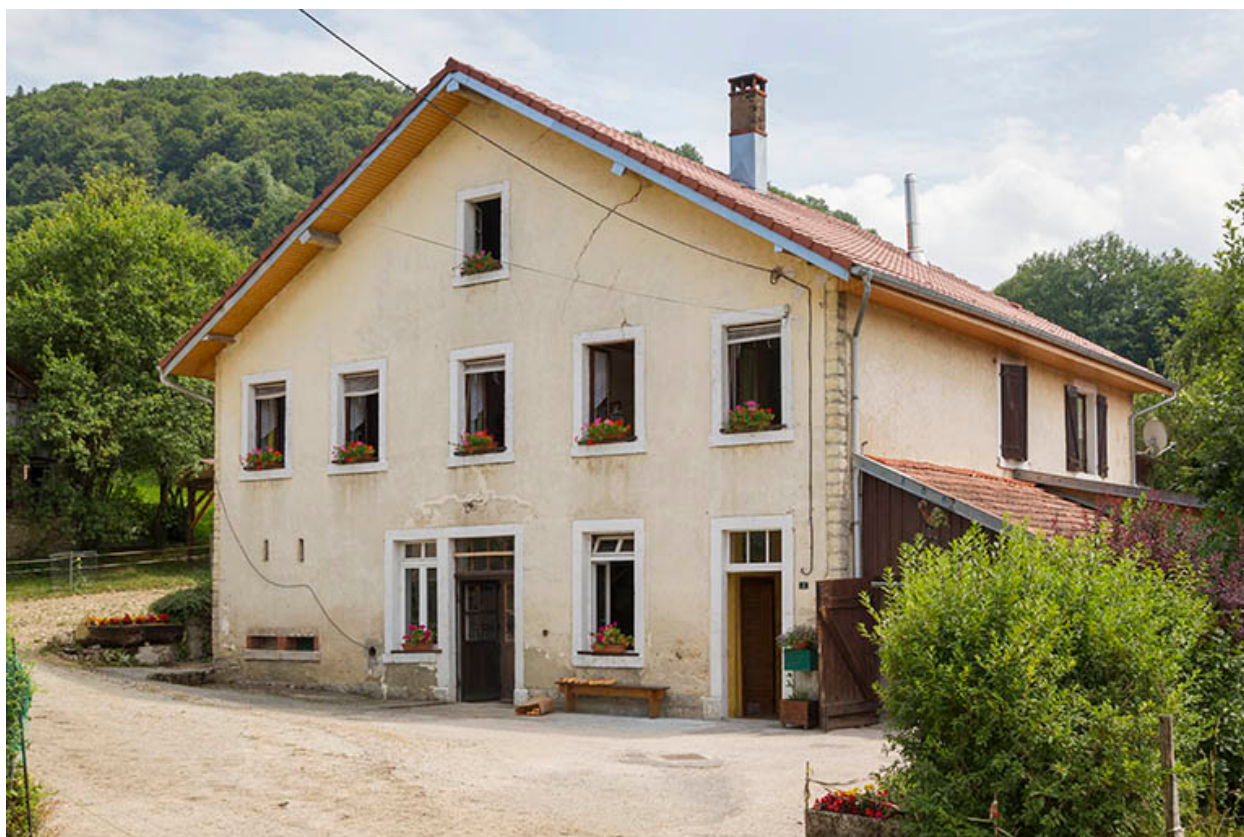
Façades antérieure et latérale droite.
