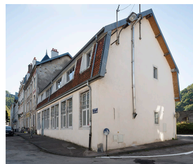
Façade et pignon ouest. Phot. Jérôme Mongreville IVR43_20172501329NUC4A
