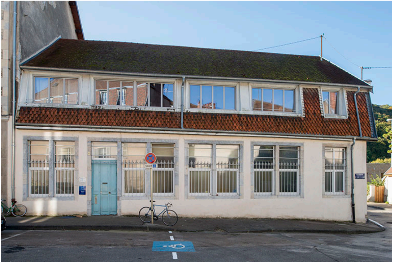
Façade nord de l'atelier.
