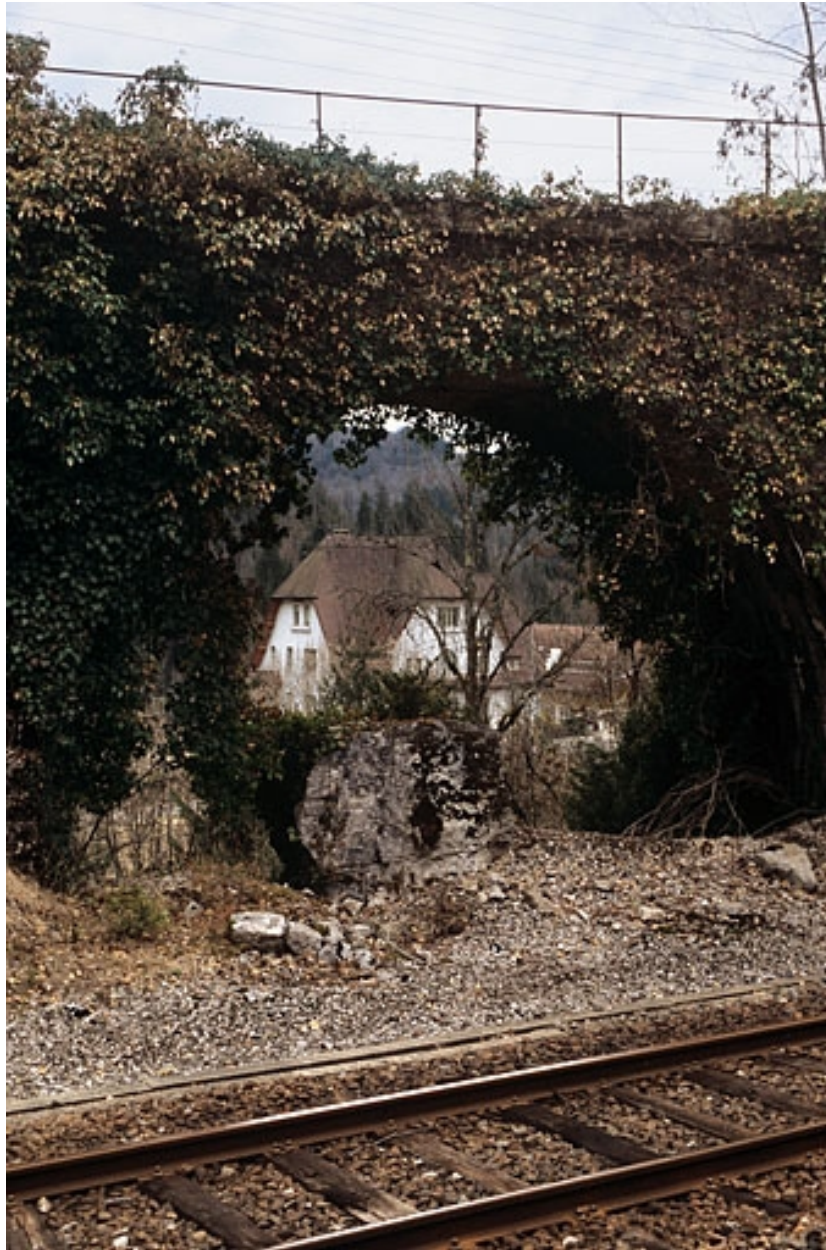
Pont du tacot : arche en plein-cintre.
