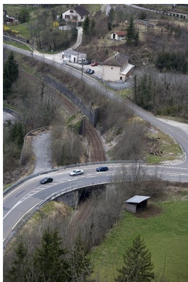
Vue d'ensemble plongeante, depuis l'est. Phot. Yves Sancey IVR43_20073900148NUCA
