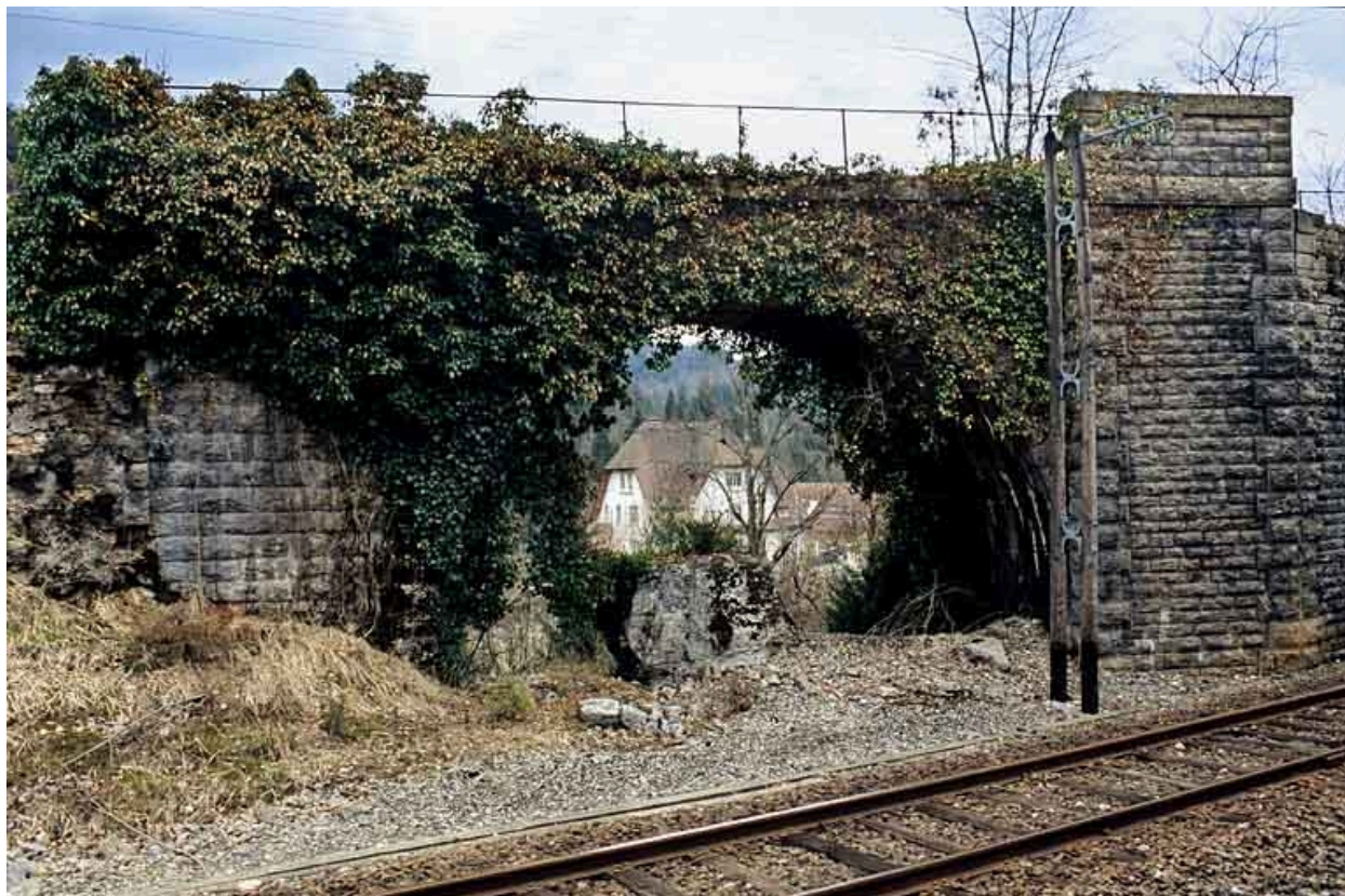
Pont du tacot : arche en plein-cintre et culée gauche.
