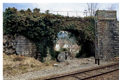
Pont du tacot : arche en plein-cintre et culée gauche. Phot. Yves Sancey IVR43_20053900927ZA
