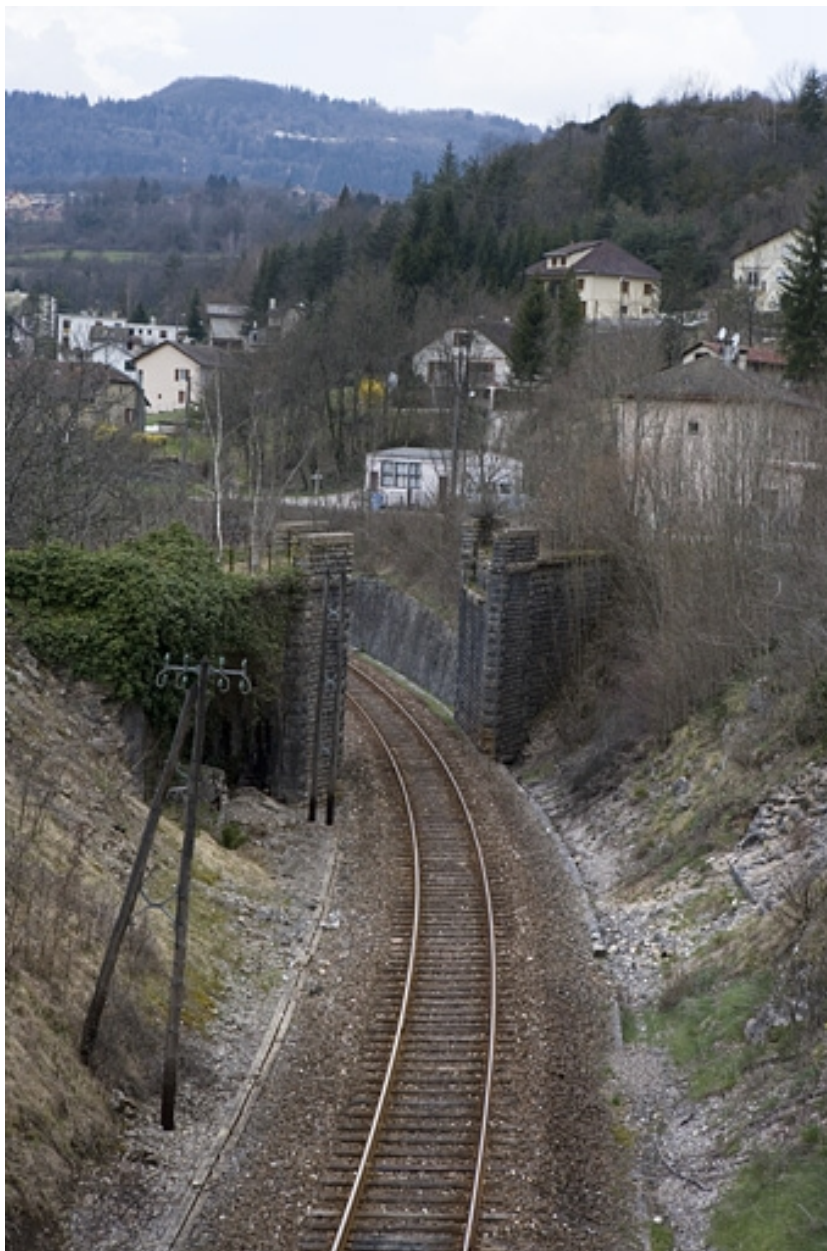
Pont du tacot : vue d'ensemble plongeante, depuis le côté Andelot-en-Montagne (est).
