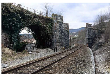
Pont du tacot : vue d'ensemble, depuis le côté Andelot-en-Montagne (est). Phot. Yves Sancey IVR43_20053900828ZA
