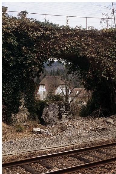
Pont du tacot : arche en plein-cintre. Phot. Yves Sancey IVR43_20053900926ZA
