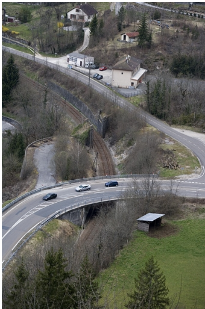
Vue d'ensemble plongeante, depuis l'est.
