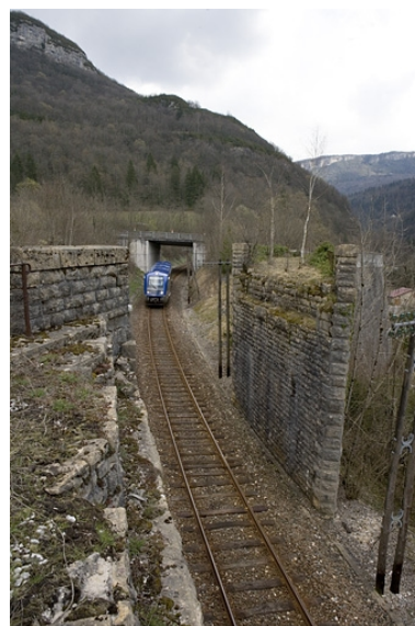
Pont du tacot et pont routier, depuis le côté La Cluse (ouest), avec autorail X 73500. Phot. Yves Sancey IVR43_20073900145NUCA
