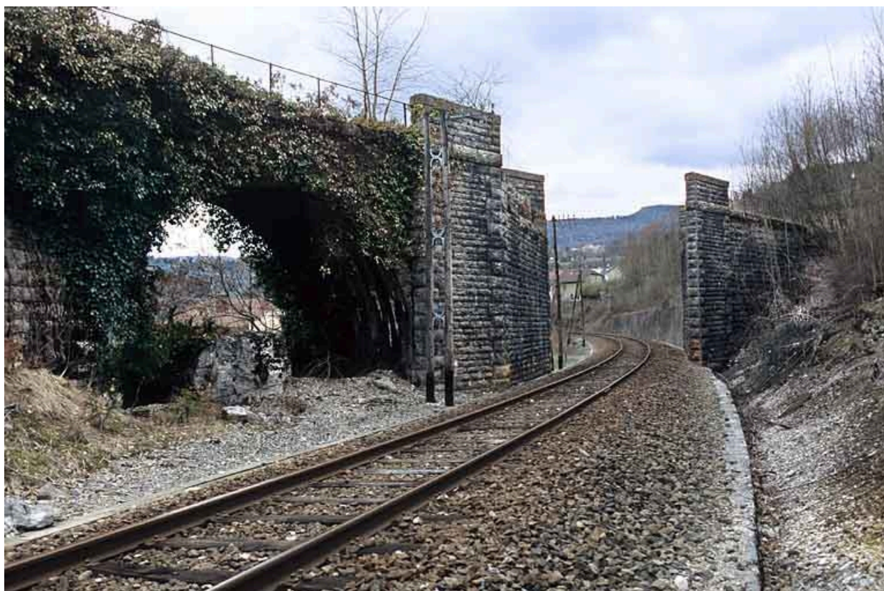
Pont du tacot : vue d'ensemble, depuis le côté Andelot-en-Montagne (est).
