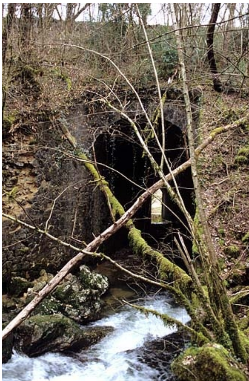
Pont sur le Lizon, depuis l'amont (nord).
