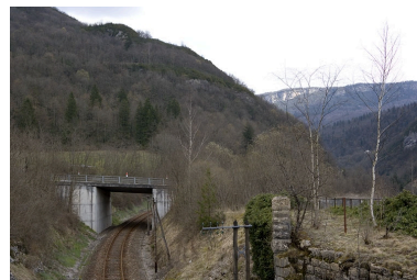
Pont routier, depuis le côté La Cluse (ouest). Phot. Yves Sancey IVR43_20073900146NUCA
