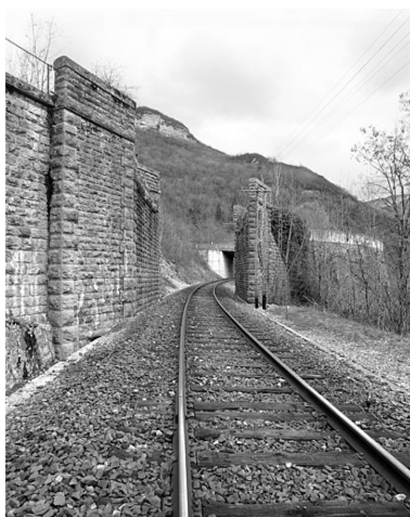
Vue d'ensemble, depuis le côté La Cluse (ouest). Phot. Yves Sancey IVR43_20053900837X
