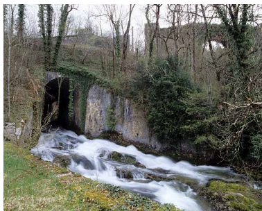
Pont sur le Lizon, depuis l'aval (sud). Pont du tacot à l'arrière-plan. Phot. Yves Sancey IVR43_20053900833XA
