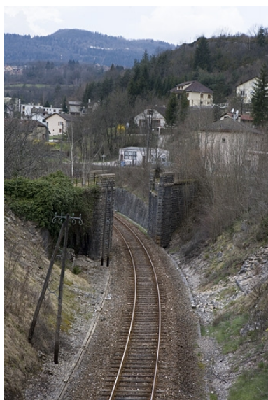
Pont du tacot : vue d'ensemble plongeante, depuis le côté Andelot-en-Montagne (est). Phot. Yves Sancey IVR43_20073900144NUCA
