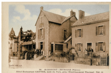
Vue ancienne (maison à droite). Autr. auteur inconnu IVR26_20195800272NUC4A
