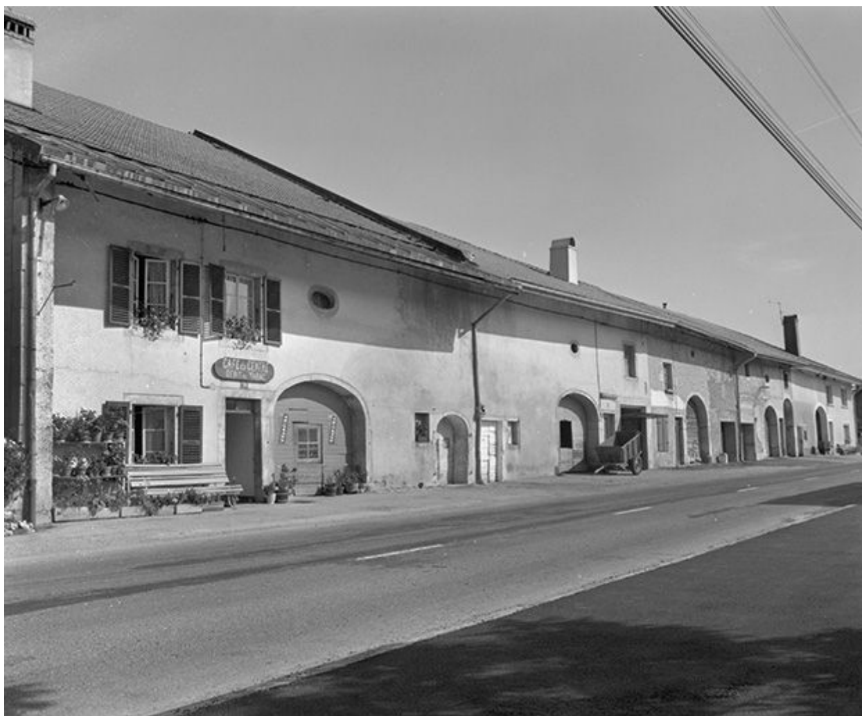
Façade sur rue.
