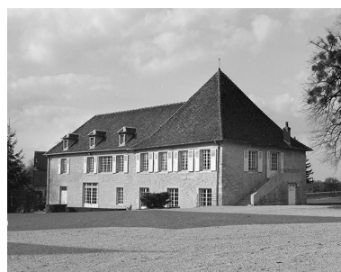
L'ancienne orangerie. Phot. Jérôme Mongreville IVR43_19853900096X
