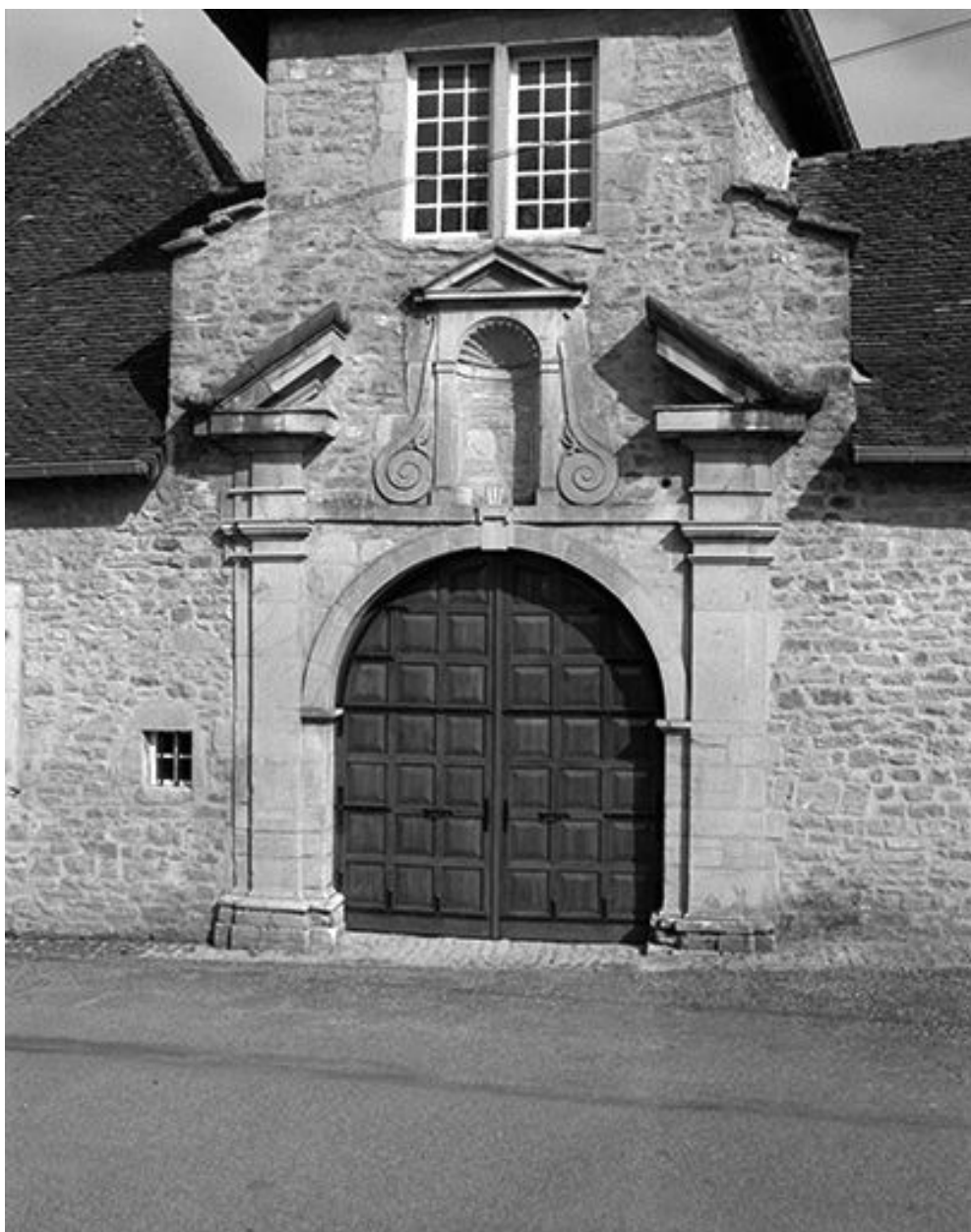
Pavillon d'entrée, le portail.
