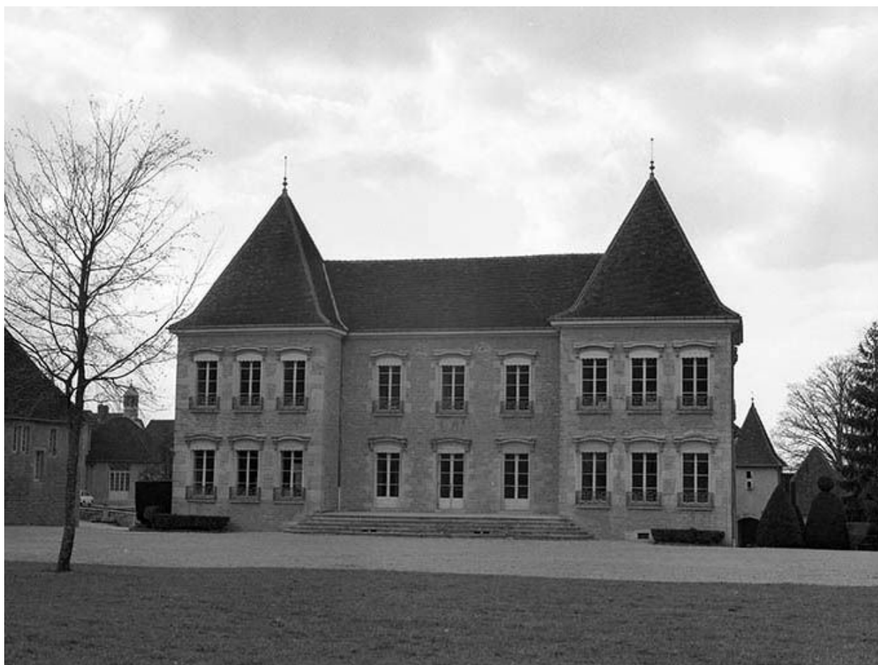
Corps du logis principal, façade principale.
