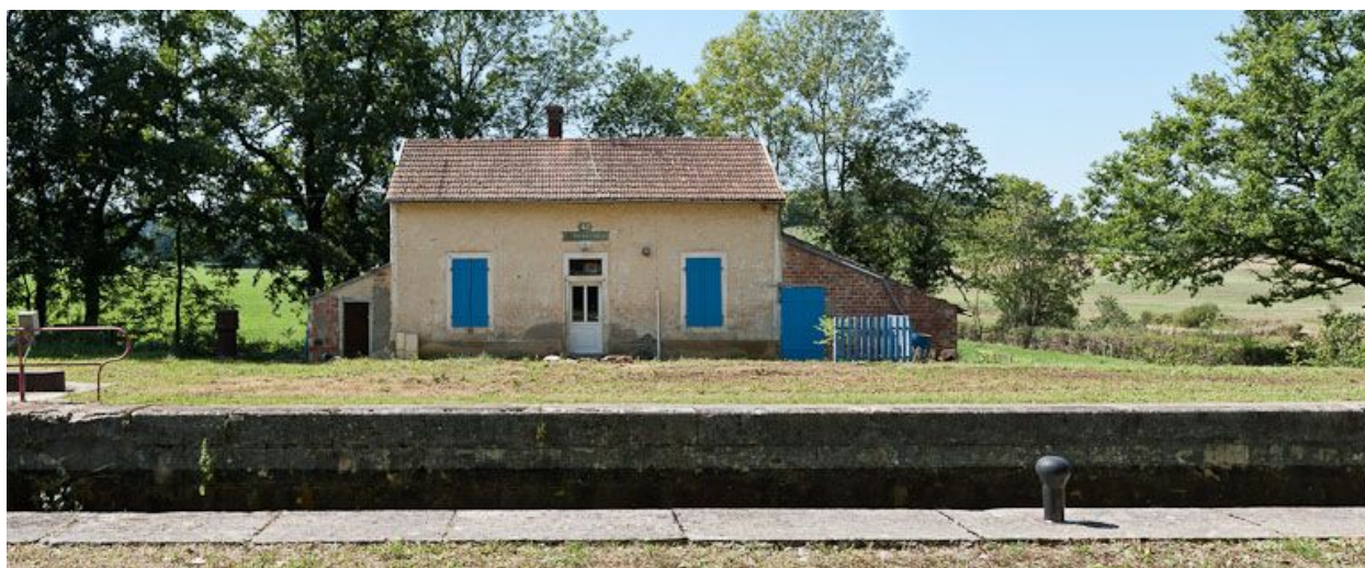
Vue de face de la maison éclusière.
