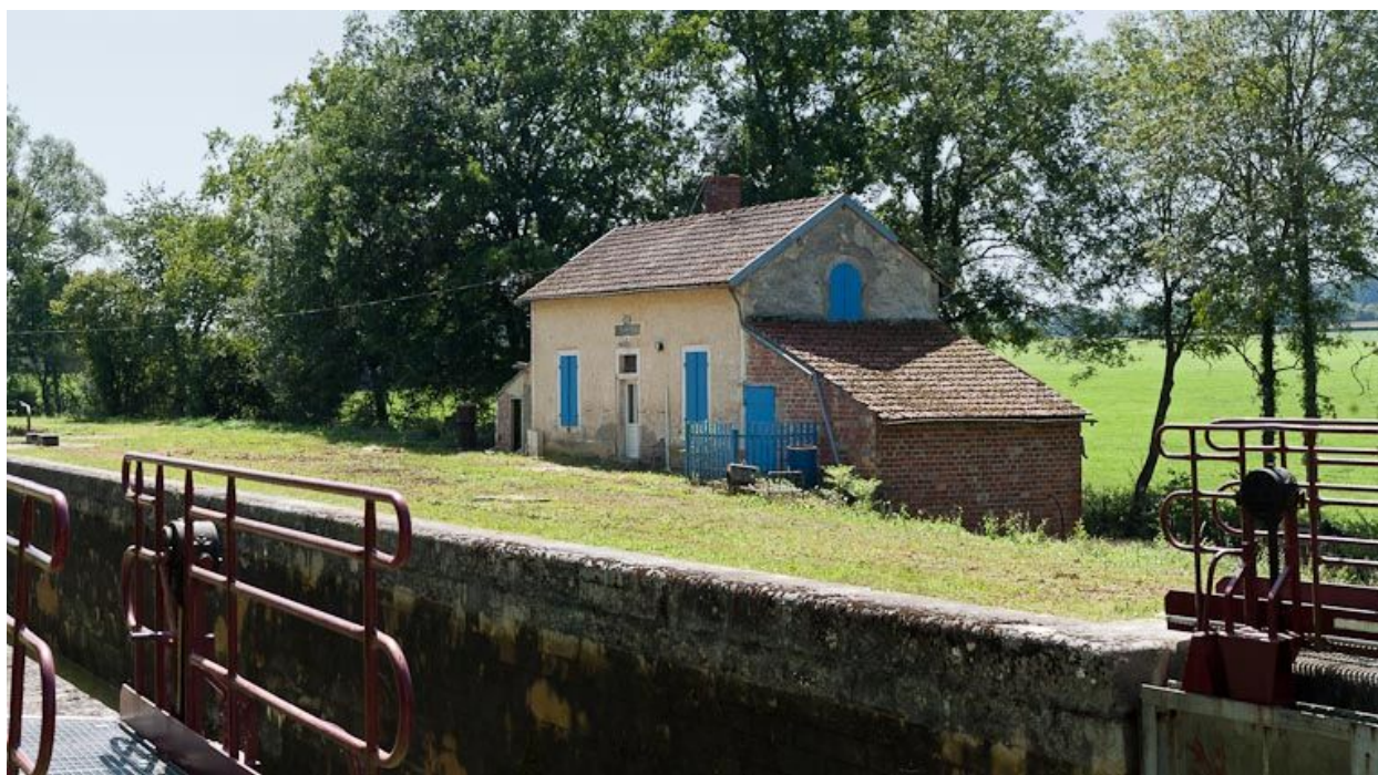
Vue d'ensemble du site d'écluse.
