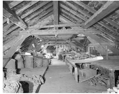
Intérieur d'un séchoir à ébauchons (bâtiment ouest). Phot. Jérôme Mongreville IVR43_19913900539X
