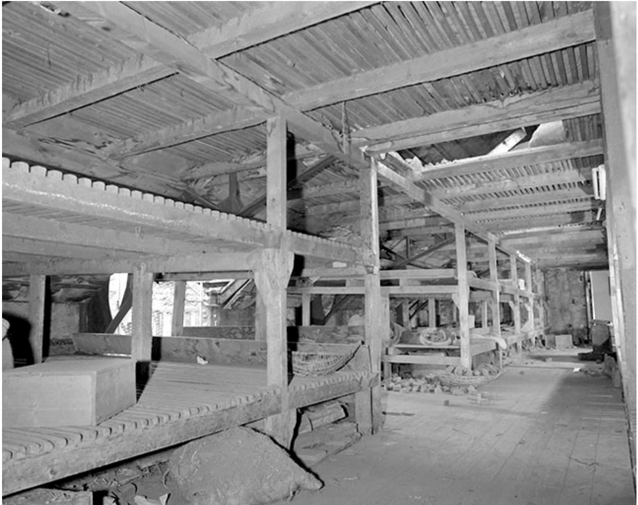
Intérieur d'un séchoir à ébauchons (bâtiment nord).
