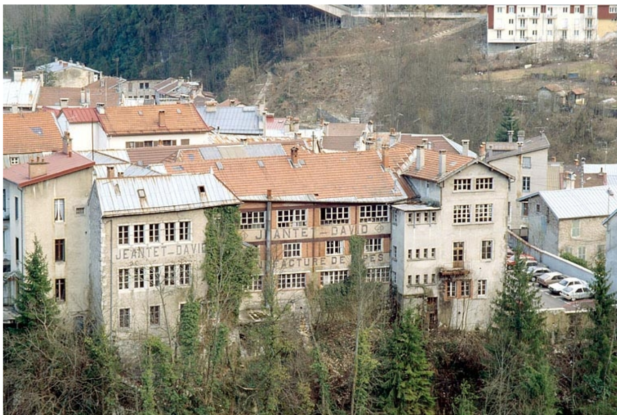
Vue d'ensemble rapprochée depuis l'ouest.
