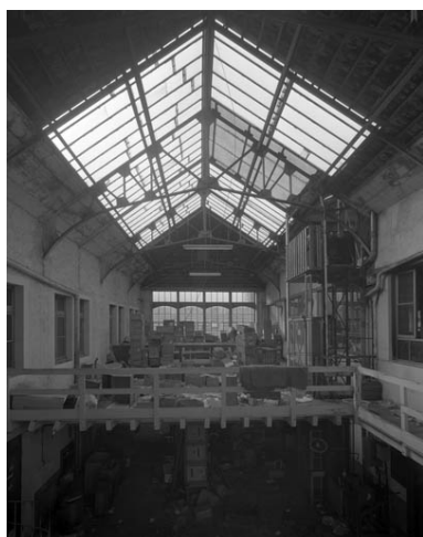
Etage de la cour couverte. Phot. Jérôme Mongreville IVR43_19913900528V
