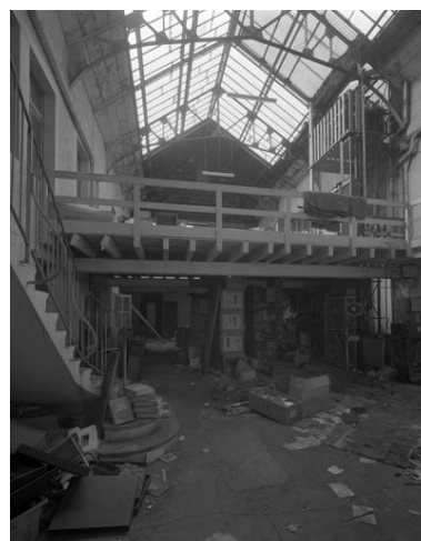
Rez-de-chaussée de la cour couverte. Phot. Jérôme Mongreville IVR43_19913900527V
