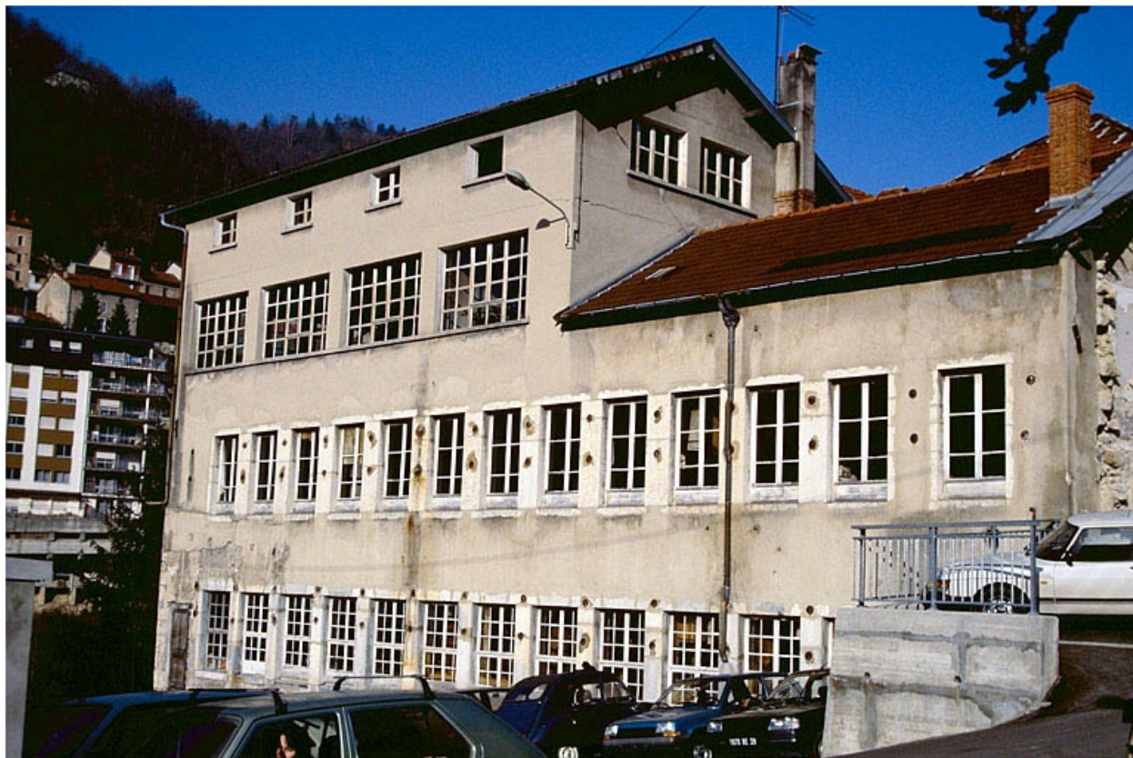
Bâtiment sud vu de trois quarts droite.
