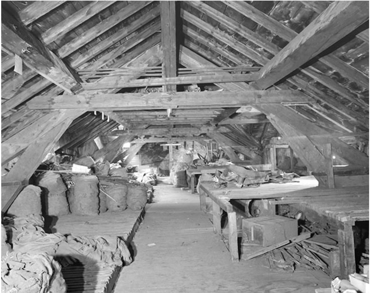
Intérieur d'un séchoir à ébauchons (bâtiment ouest).
