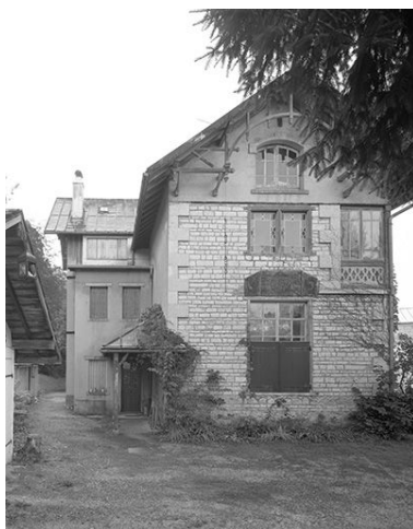
Vue rapprochée de la façade nord-ouest. Phot. Jérôme Mongreville IVR43_20003900422V
