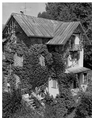
Façades sud-est et sud- ouest vues de trois quarts. Phot. Jérôme Mongreville IVR43_20003900428X
