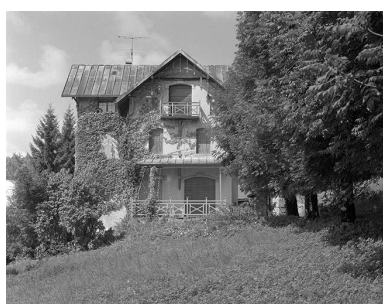
Façade sud-est. Phot. Jérôme Mongreville IVR43_20003900426X
