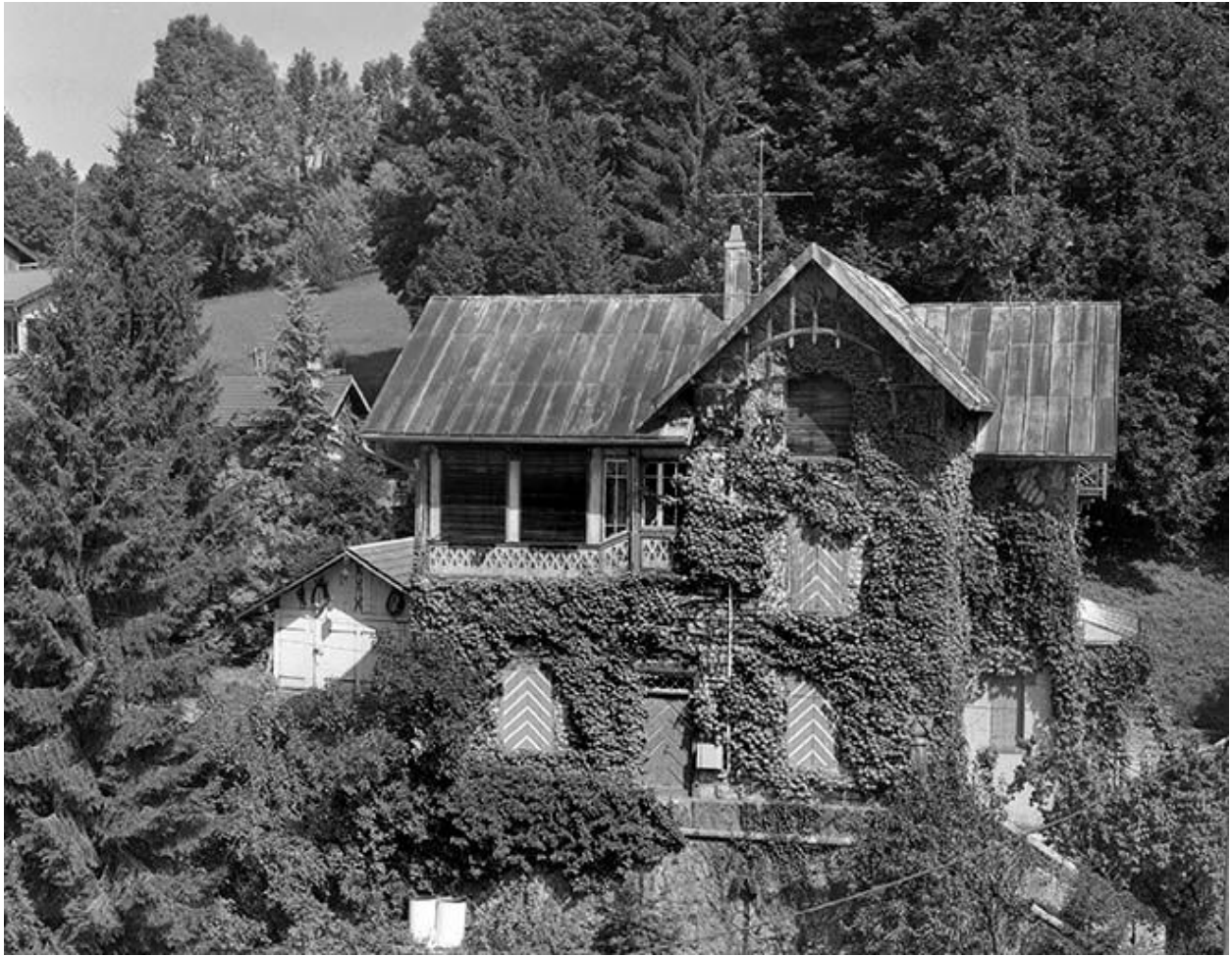
Vue éloignée de la façade sud-ouest.
