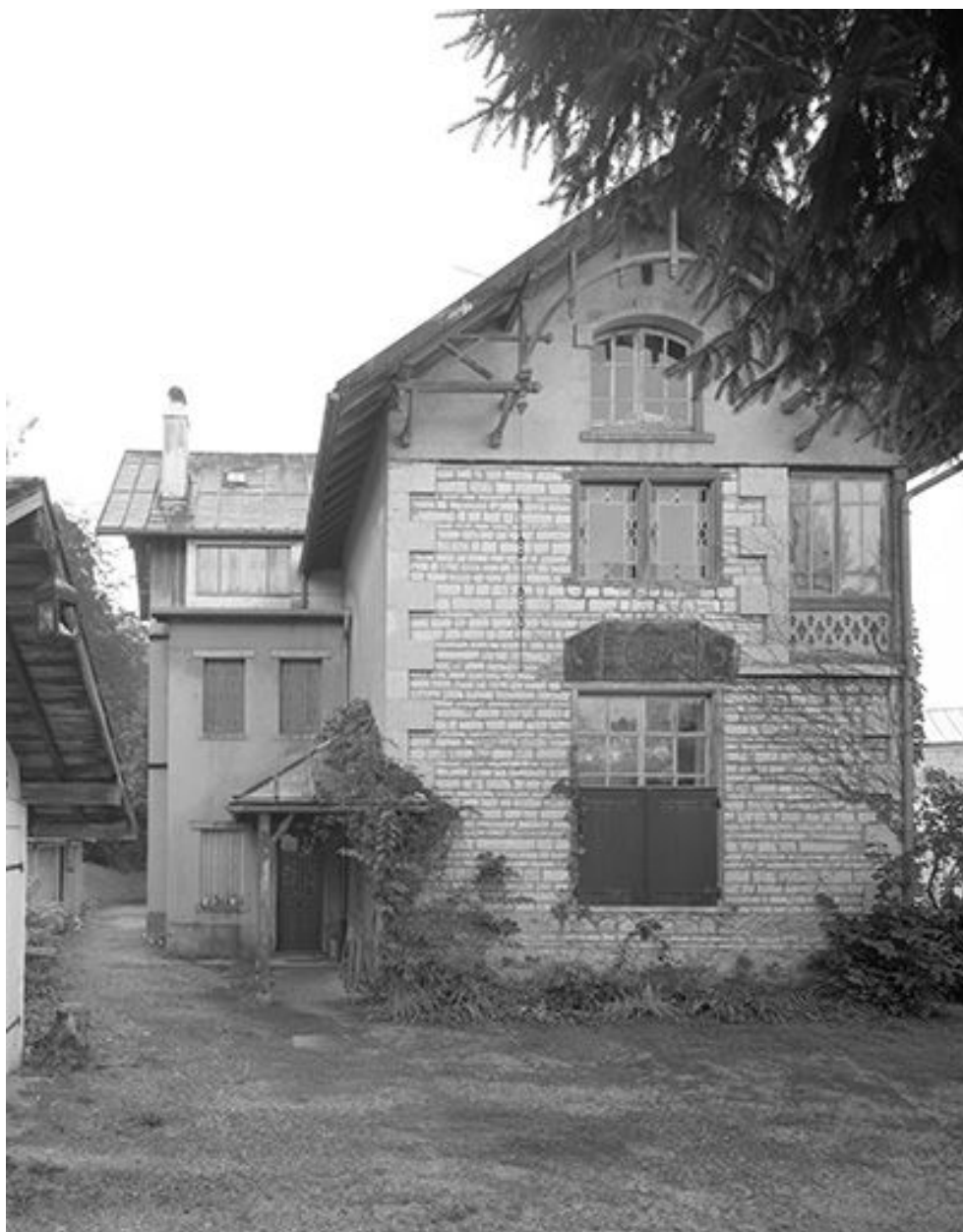
Vue rapprochée de la façade nord-ouest.
