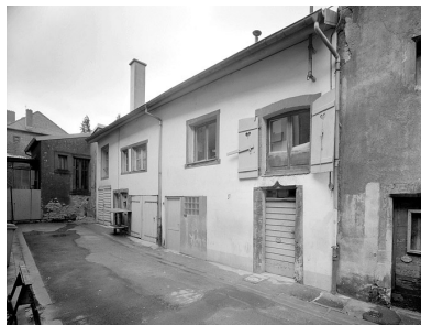
Façade sur rue. Phot. Jérôme Mongreville IVR43_19882500041V
