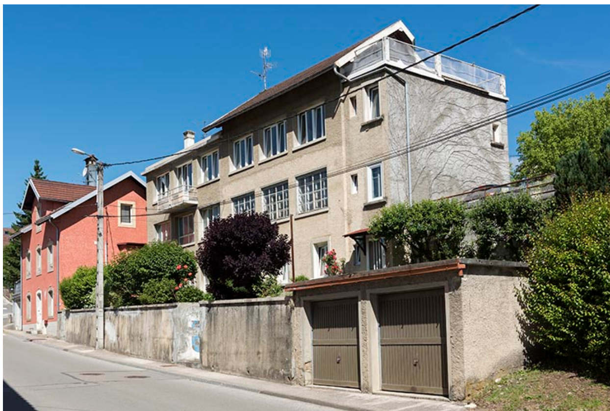
Façades sud et est.
