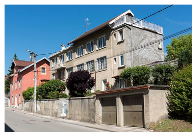
Façades sud et est.
