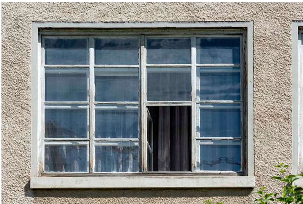
Façade sud : fenêtre d'atelier.
