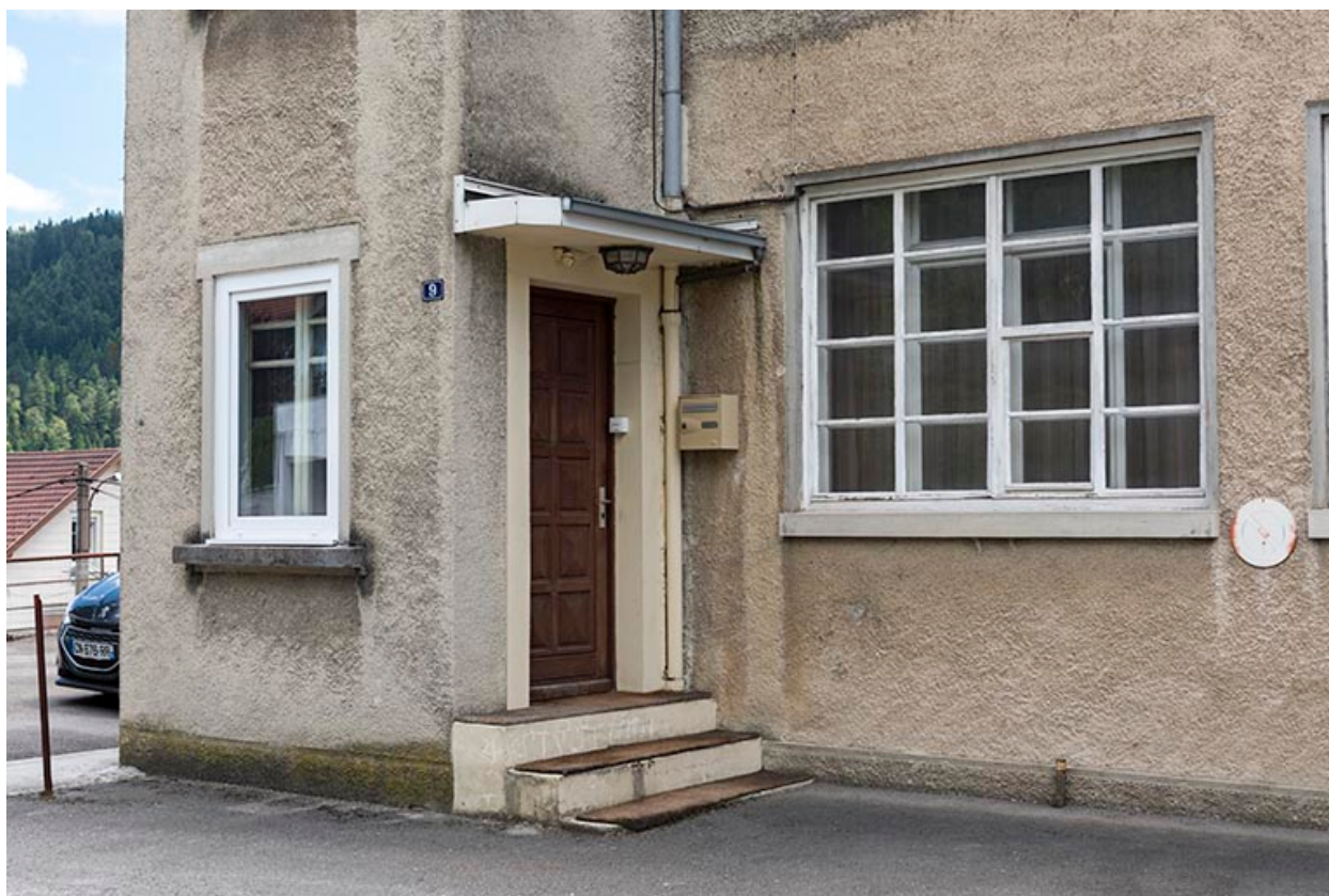
Façade nord : entrée rue Pasteur.
