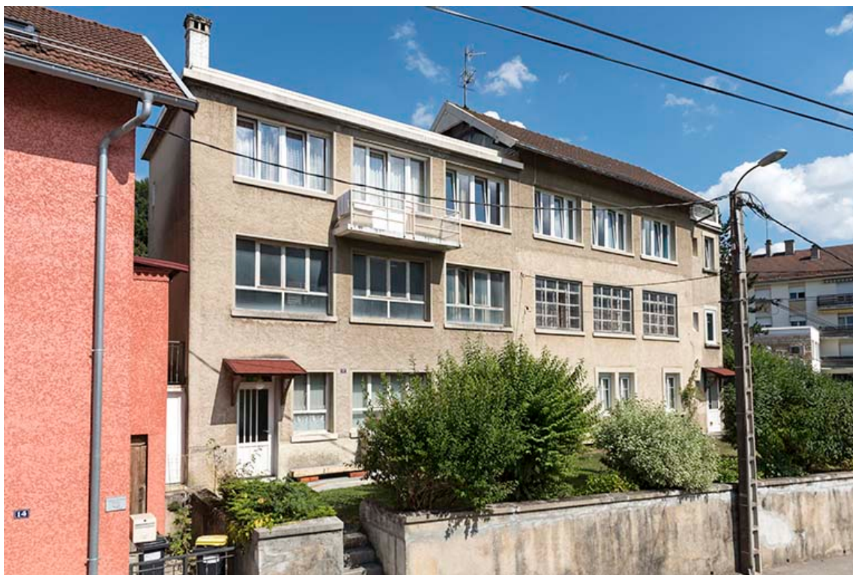
Façade sud, de trois quarts gauche.
