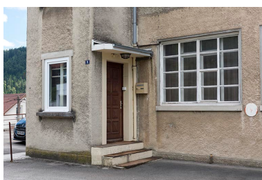
Façade nord : entrée rue Pasteur.
