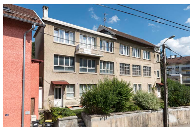
Façade sud, de trois quarts gauche.
