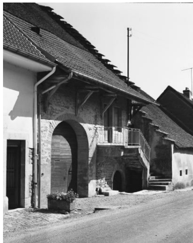
Façade antérieure. Phot. Dominique Dominguez IVR43_19803900030X
