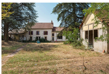
Usine de mise en bouteilles (au fond) et bureau (à droite). Phot. Pierre-Marie Barbe-Richaud IVR26_20205800455NUC4A
