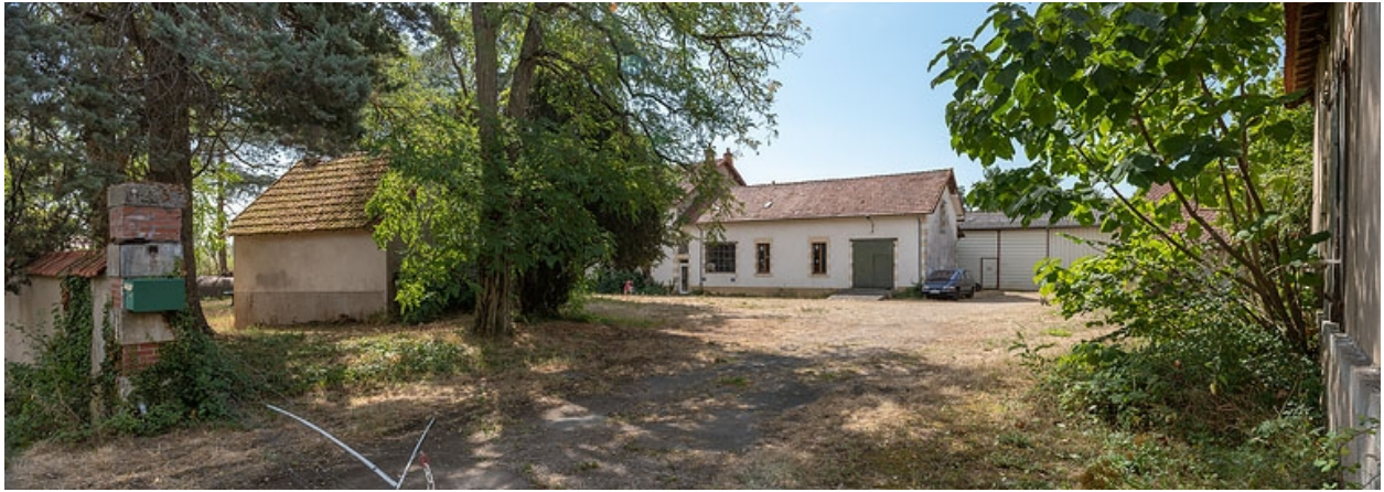
Usine de mise en bouteilles (au fond), bureau (à gauche) et dépendance (à droite).
