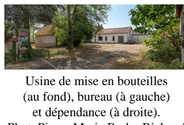
Usine de mise en bouteilles (au fond), bureau (à gauche) et dépendance (à droite).
